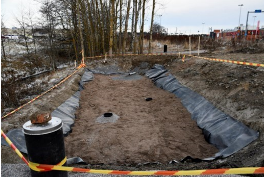
Kuva 7. Länsikeskuksen biosuodatusrakenne ennen maisemointia ja kasvillisuusistutuksia.
