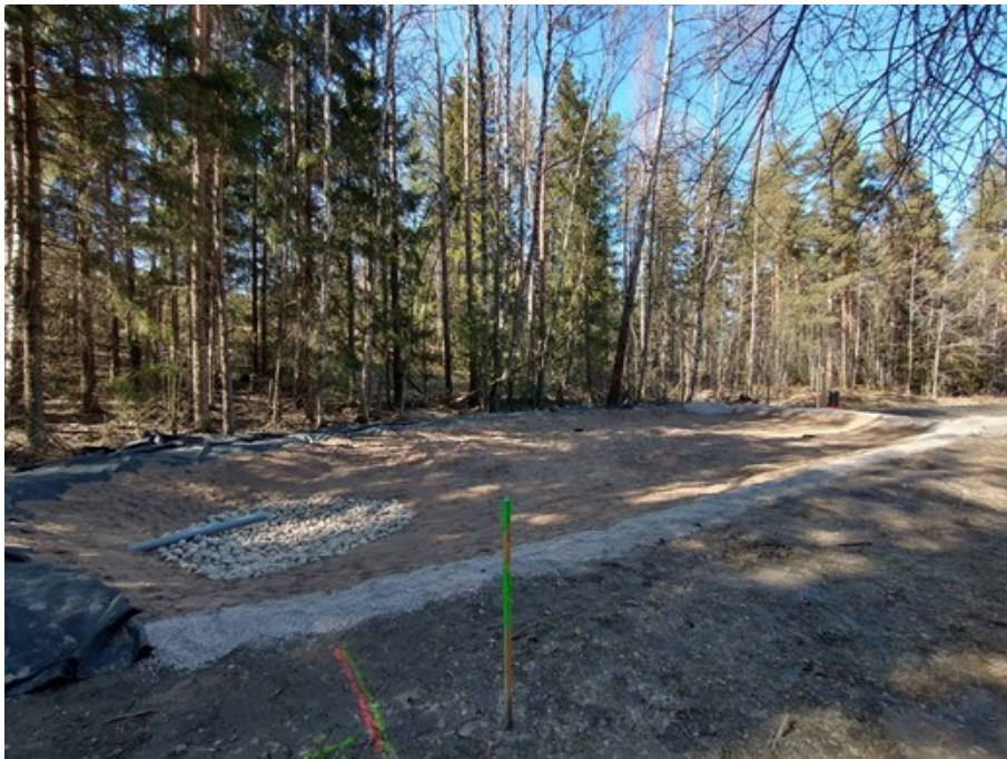
Kuva 8. Avantin biosuodatusrakenne ennen kasvillisuuden istuttamista.
