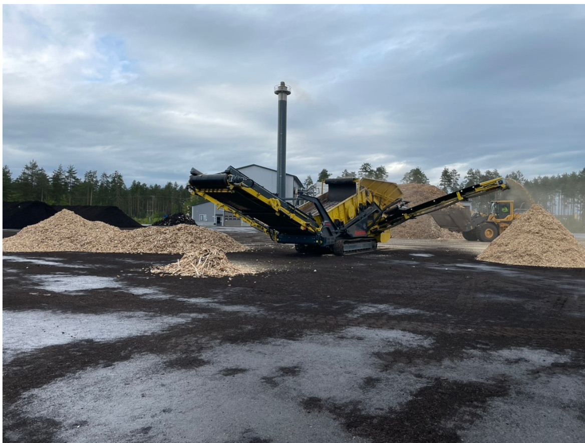
Kuva 9 Kierrätyspuumurskeen seulonta tasoseulalla
