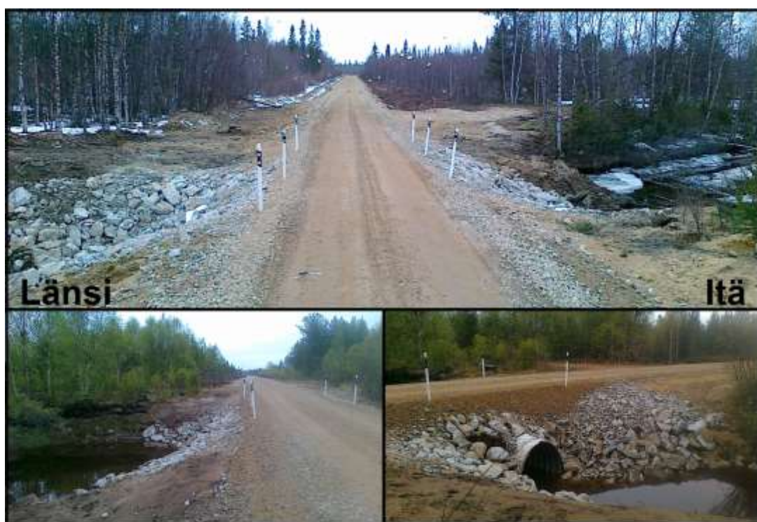
Kuvio 14. Paalu 435. Akujärvenkanavan rummun luiskat vahvistettu louheella
