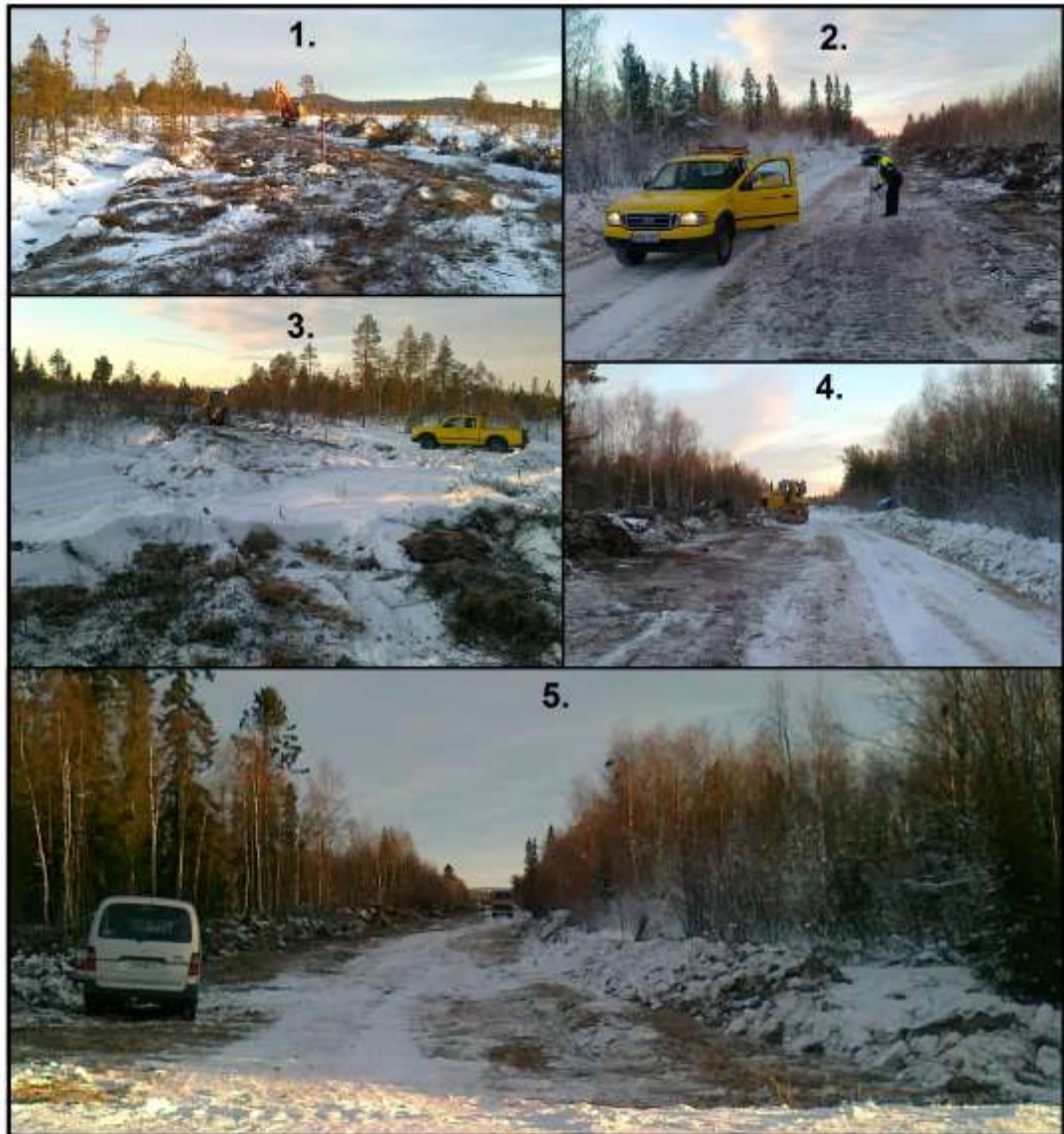
Kuvio 3. Jäädetytyn tiepohjan raivaus, tasmaus ja tien linjaus 08.02.2012
