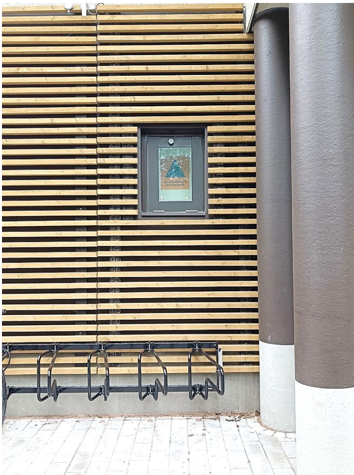
Kuva 30: Väestönsuojat suojaavat räjähdys- ja sirpalevaikutuksilta, rakennusten sortumilta, paineaalloilta, säteilyltä sekä terveydelle vaarallisilta aineilta. Kuvassa Tampereen Kalevan kerrostalon väestönsuojan suojaluokkuun kiinnitetty, kansainvälinen tunnus. (Kuva: Pönnighaus, 2023)
