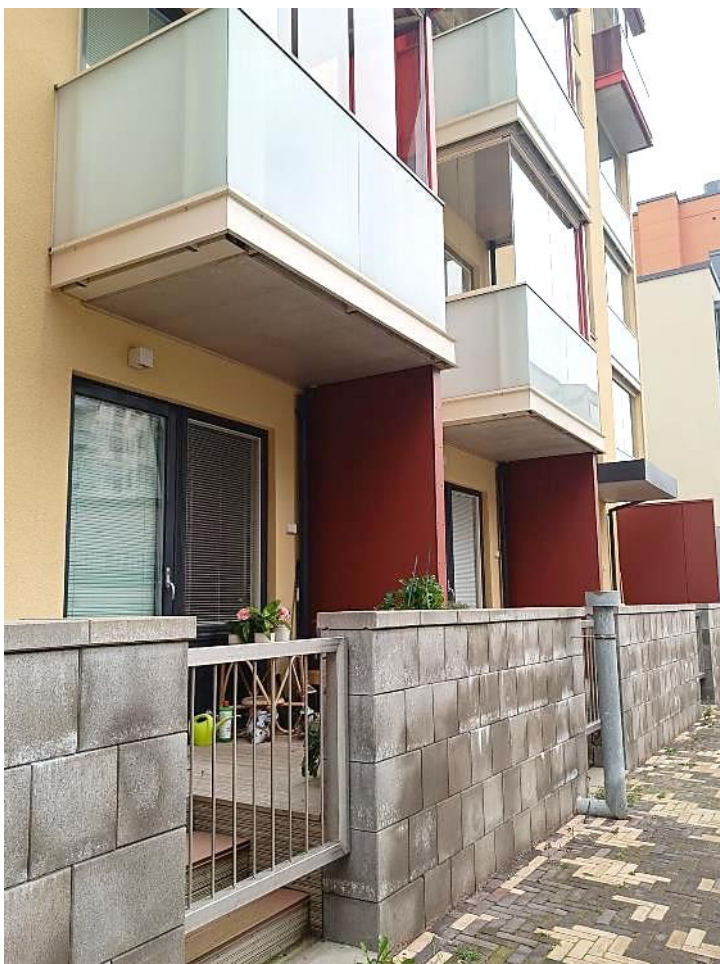
Kuva 7: Pieni puoliyksityinen terassi kadun puolelle voi toimia siirtymävyöhykkeenä. Terassilla voidaan esimerkiksi keskustella naapurin kanssa ja tarkkailla samalla, mitä kadun puolella tapahtuu. Kuvassa kerrostalon terassipihoja Tampereen Härmälänrannassa. (Kuva: Pönnighaus, 2023)
