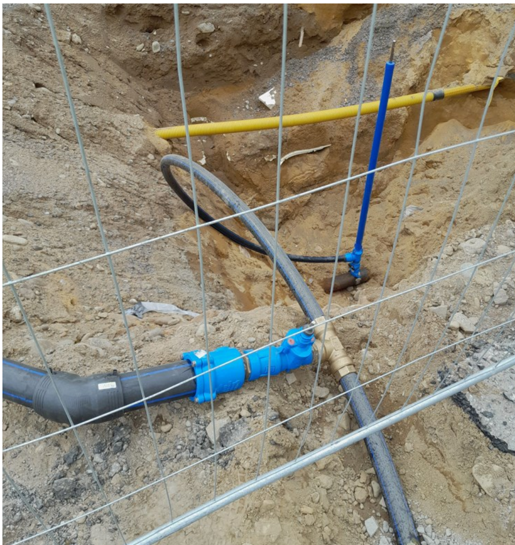
KUVA 5. Väliaikainen vedensyöttö yhdistettynä rautaiseen vesijohtoon (Buildie 2022)
