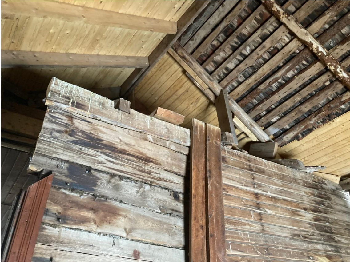
KUVA 7. Porrashuoneen seinän sahattuja hirsiiä ja olemassa olevaa vesikatetta.
