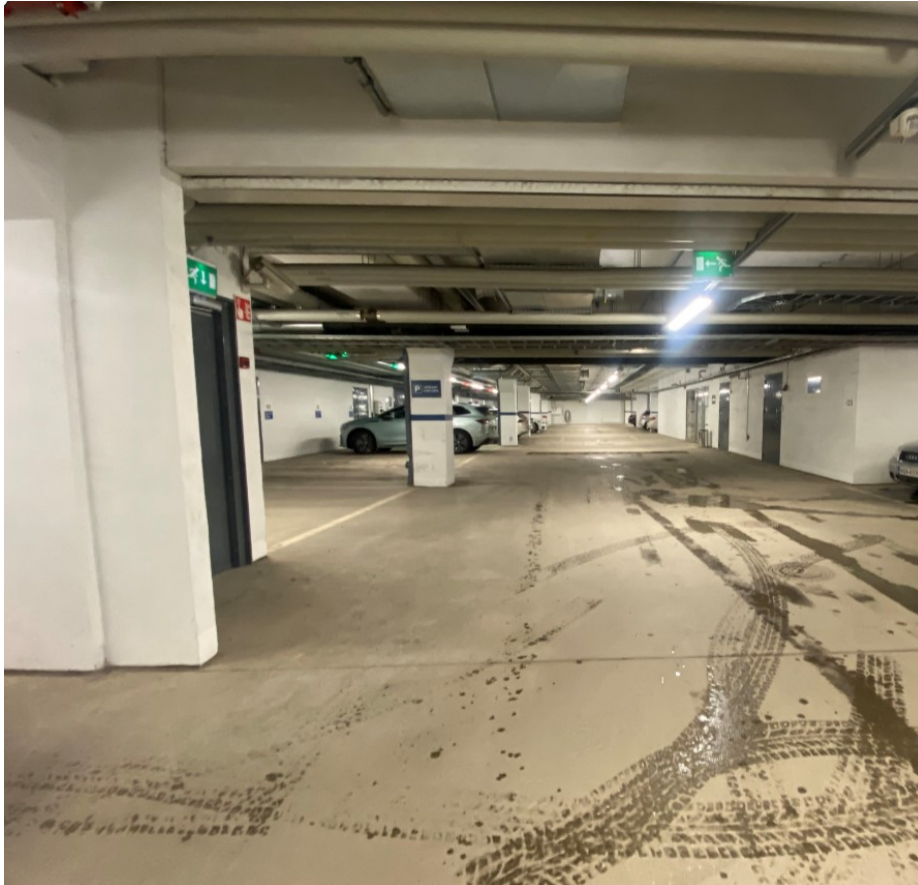
Kuva 14. Parkkihallin yleiskuvaa -1 kerroksesta
