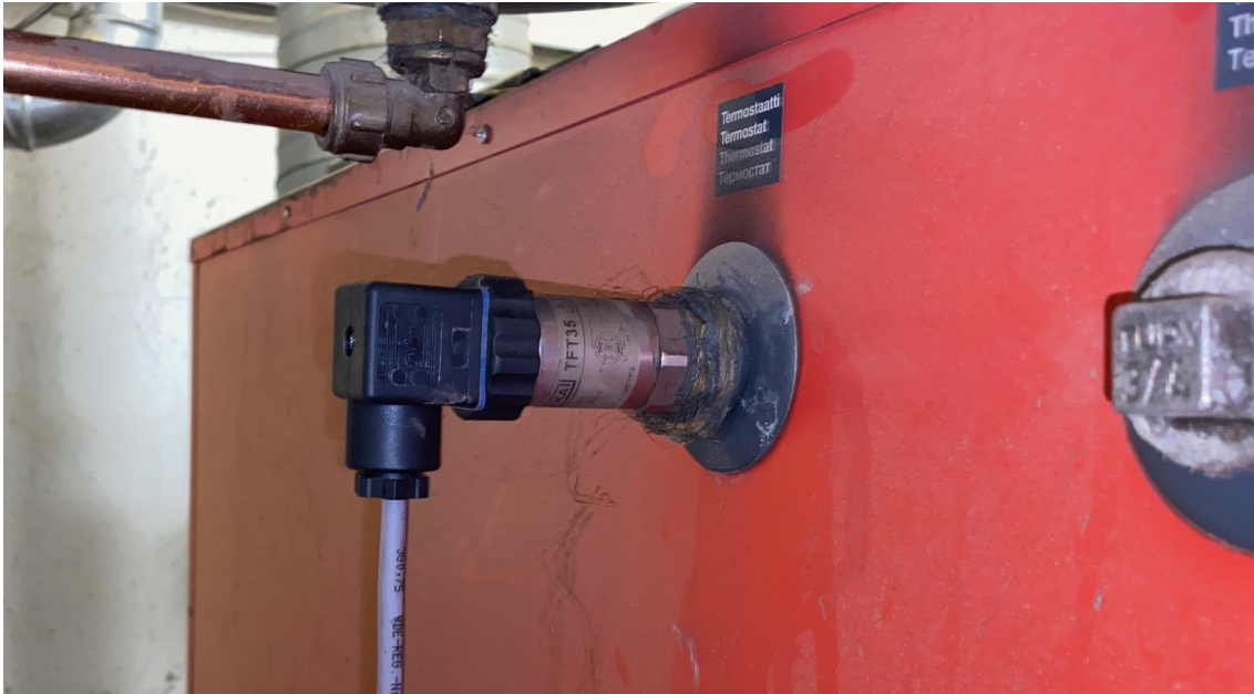
KUVA 49. Kattilaveden lämpötila-anturi
