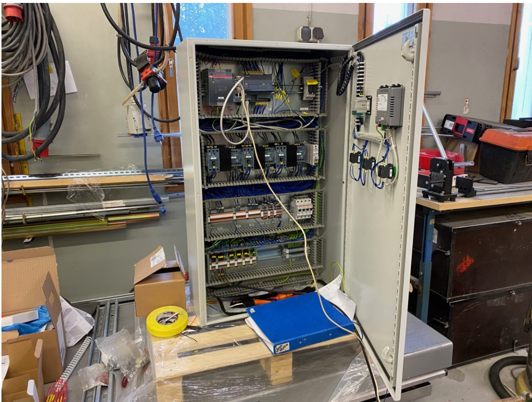
KUVA 47. Keskus testausvaiheessa
