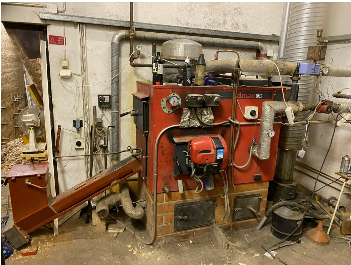
KUVA 17. Kattila ja nousuruuvi
