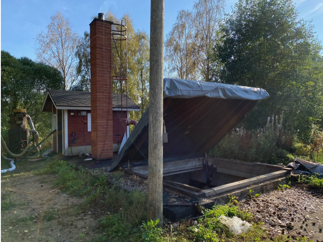
KUVA 12. Lämpölaitoksen hakesiilon luukku auki
