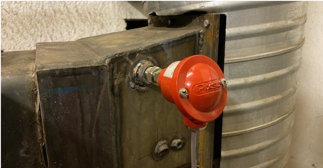
KUVA 52. Savukaasun lämpötila-anturi
