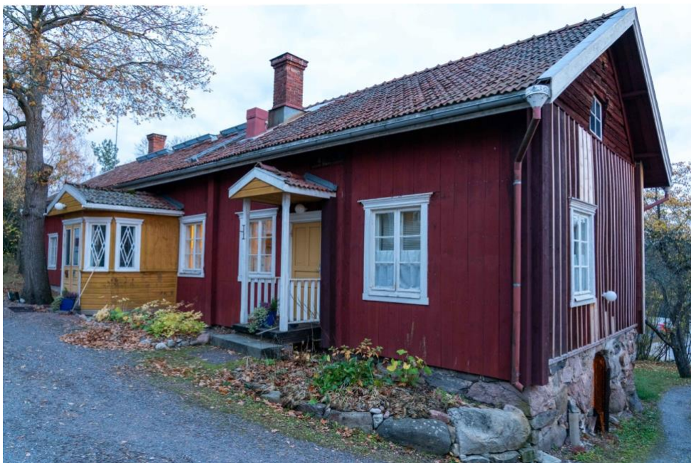
KUVA 4. Yli-Taimon tilan päärakennus 21.10.2022. (Kuva: Ville Hautakangas 2022).
