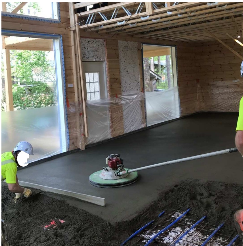
KUVA 3. Maakostealla betonilla levitys ja hierto voidaan toteuttaa samaan aikaan. Hiertämisessä käytetään yleisesti levyhiertokoneita (Bekason Oy).
