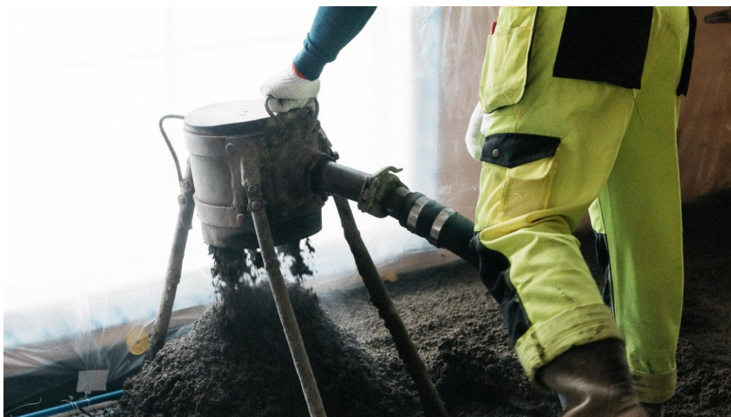
KUVA 2. Työmaabetonin massa siirretään betoniyksiköstä kohteeseen levityspöntön avulla (Bekason Oy).
