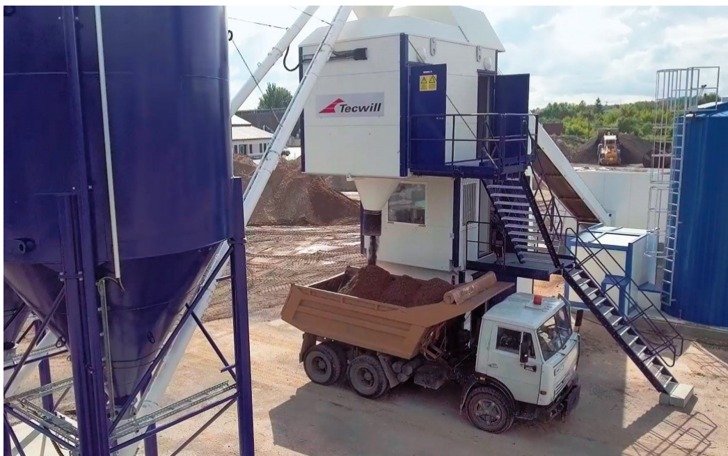
KUVA 5. Maakostean valmisbetonin lyhyeen siirtoon paras vaihtoehto on joko niin sanotun allasauton tai kuorma-auton lava, mutta huolellinen suojaus on tehtävä siitä huolimatta (Tecwill).
