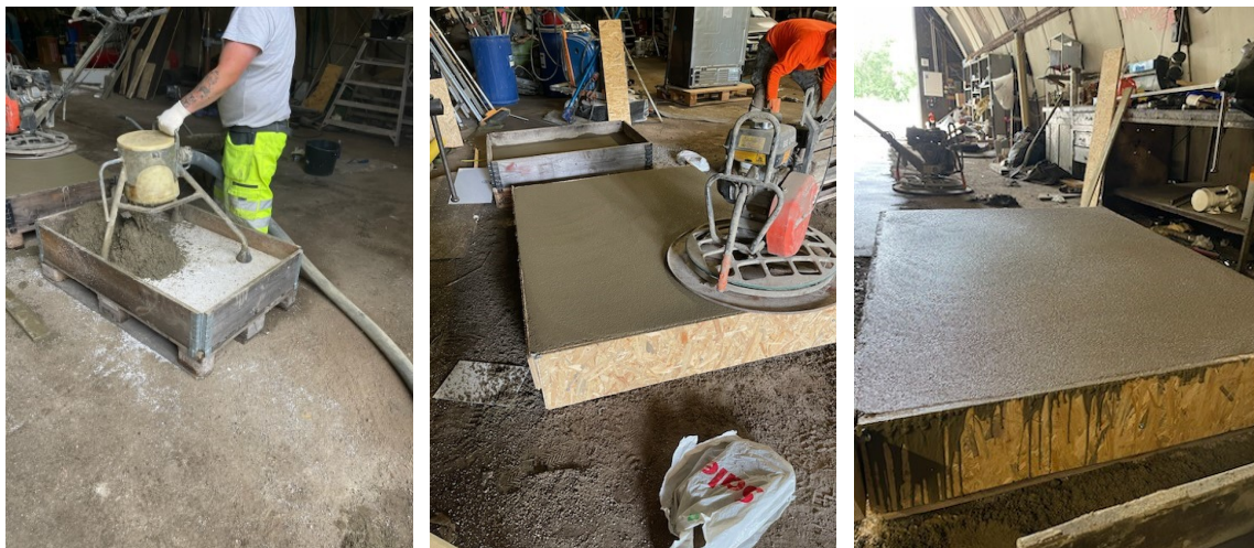
KUVA 35. Betonikoekappaleiden valamista (Korolainen 2023, CC BY-SA)
