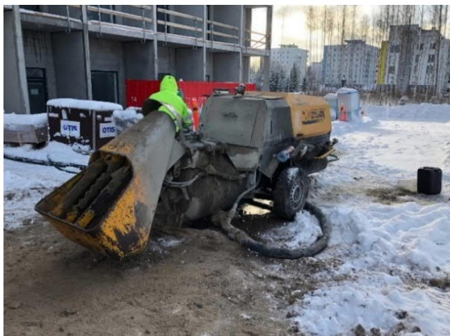
KUVA 4. Perinteisen työmaabetonin betonimylly (Husu 2019)
