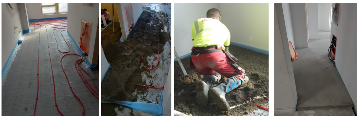
KUVA 14. Massan oikea koostumus, olosuhteet ja jälkihoito ovat tärkeimmät asiat halkeilun hallinnassa (Korolainen 2023, CC BY-SA).
