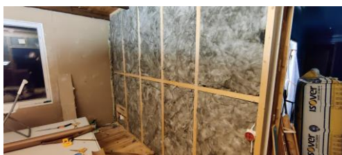
4.2.3 Bild: Applicering av stenull
