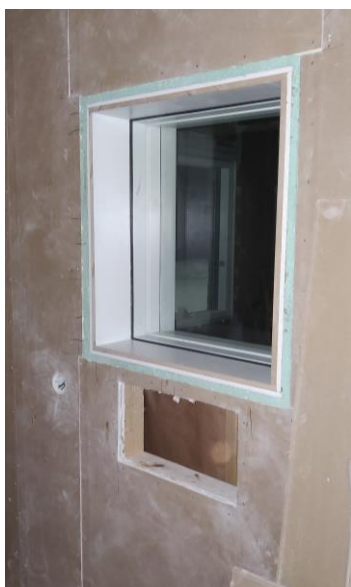
4.3.1 Bild: Kontrollrum dörröppning ombyggd
