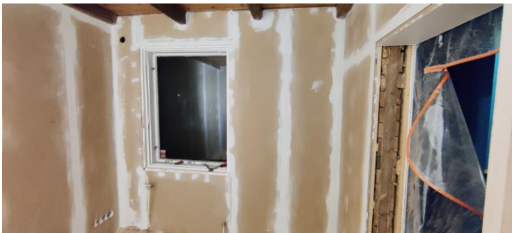
4.1.2 Bild: Produktionsrummet spacklat
