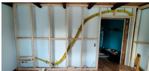
4.2.1 Bild: Ram för dubbel vägg med kabelrör
