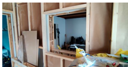
4.2.2 Bild: Ram för fönster mot kontrollrum
