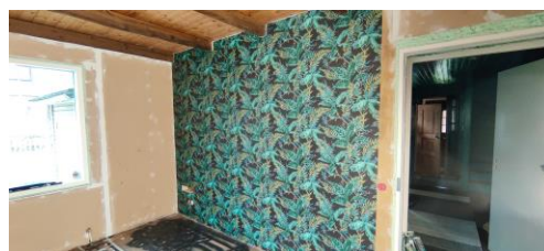
4.2.4 Bild: Tapetsering påbörjad på gips-skivor
