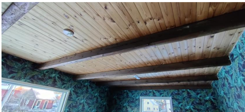
6.0.1 Bild: Inspelningsrummets tak
