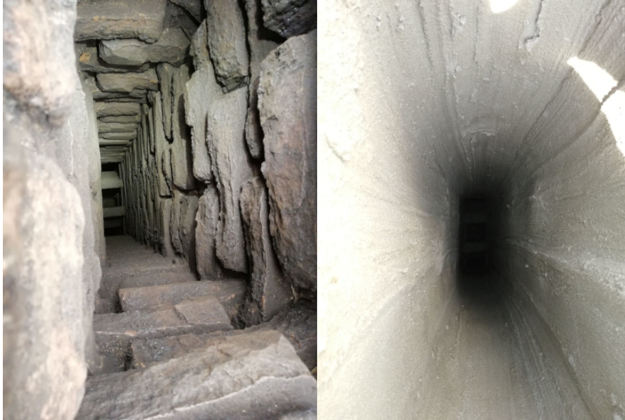
Kuva 5. Kunnostettu hormi ennen ja jälkeen (Lindfors Finland Oy 2023).
