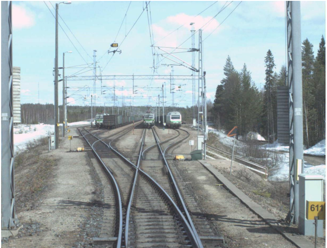
Kuvio 14. Liikennepaikan länsipään vaihteet V611, V612, V615 ja V613 alkuvuonna 2020 (Ratakuvapalvelu 2020)
