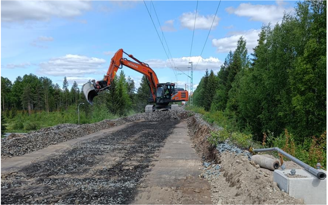
Kuvio 9. Radan välikerroksen rakentamista mallipohjaisesti
