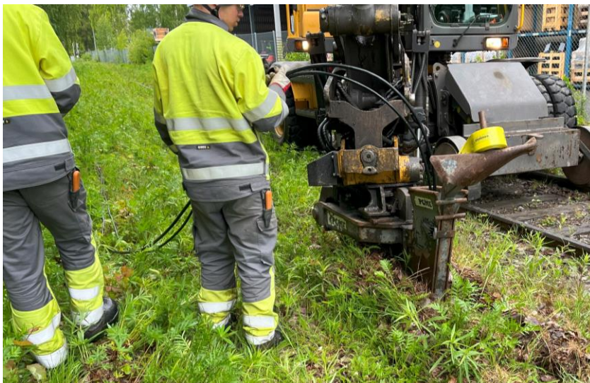
Kuva 6. Kaapelin asennus auraamalla
