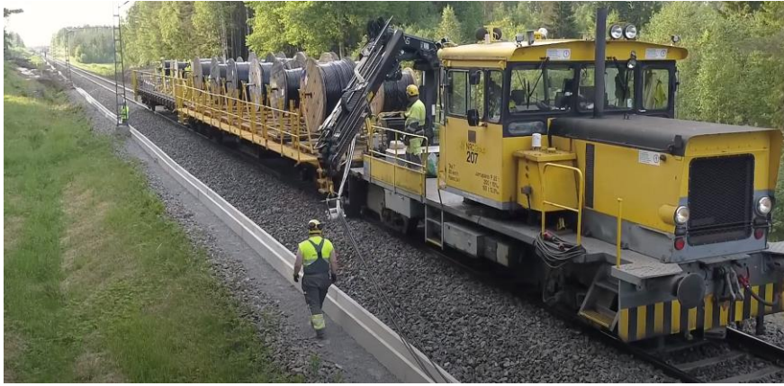
Kuva 3. Kaapelointia ratakuorma-auto ja kaapelivaunuyhdistelmällä (NRC Group 2020.)
