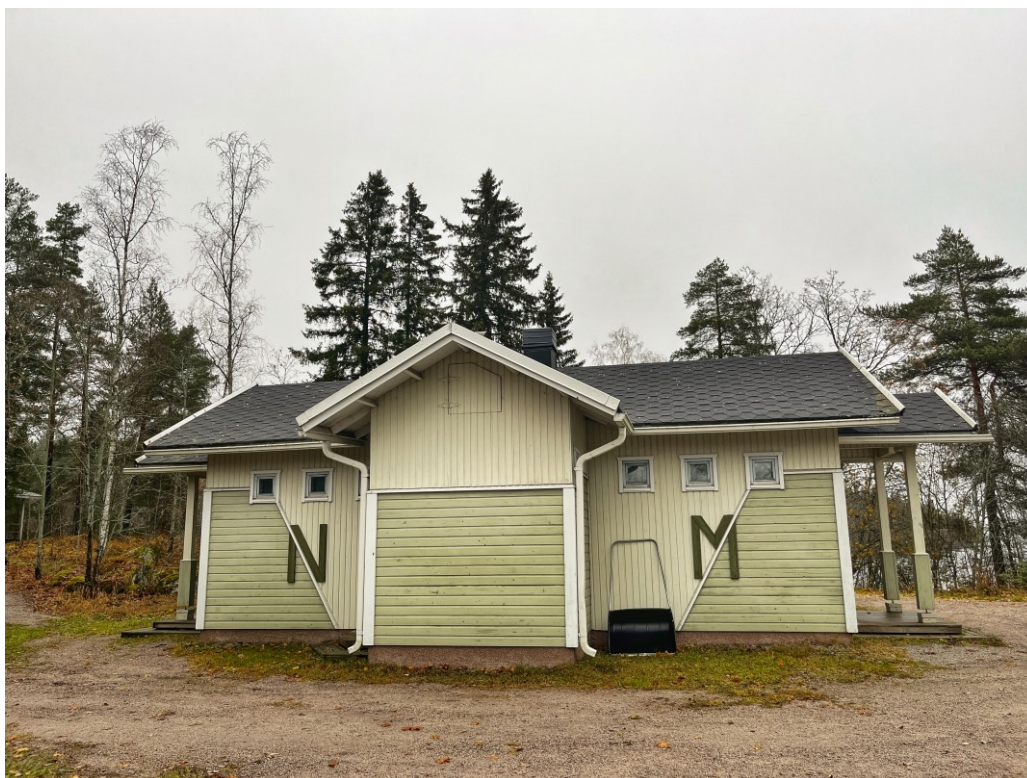
KUVA 64. Wc-rakennus. (Kuva: Melina Avelin 2023).
