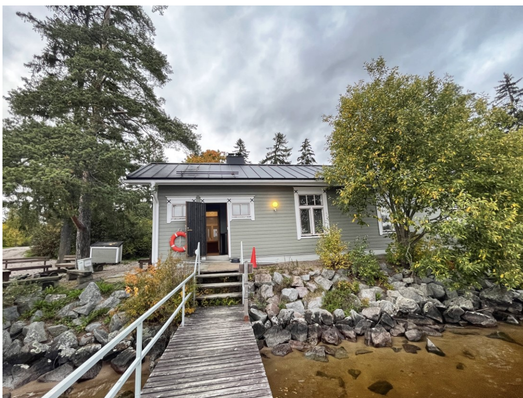
KUVA 63. Sauna peruskorjauksen jälkeen. (Kuva: Melina Avelin 2023).
