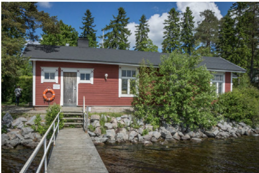
KUVA 62. Sauna ennen 2021 peruskorjausta. Kuva: Pasi Vierimaa. (Arkkitehtitoimisto Neva Oy 2015).
