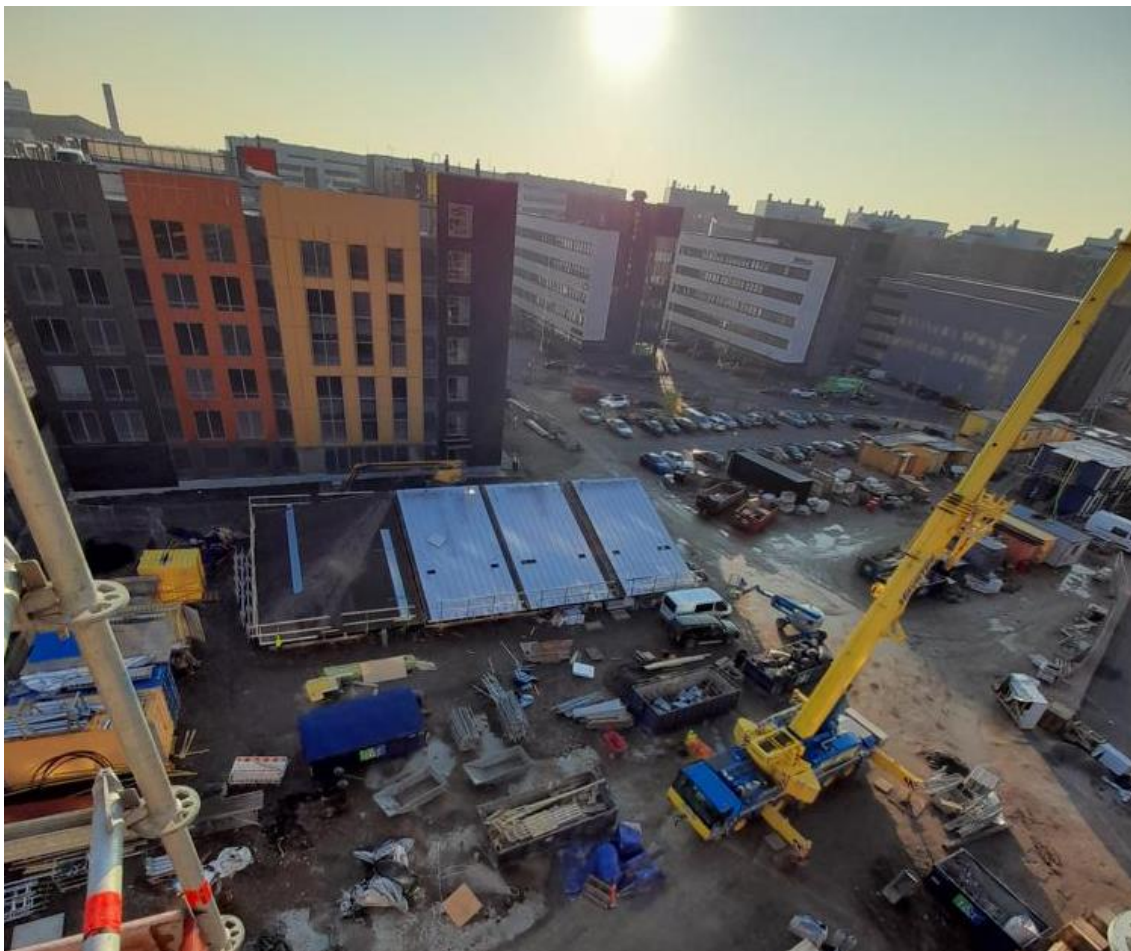
Kuva 5. vesikaton lohkojen jaosta vesikaton korkeudelta kuvattuna. (Alsaifi 2022)
