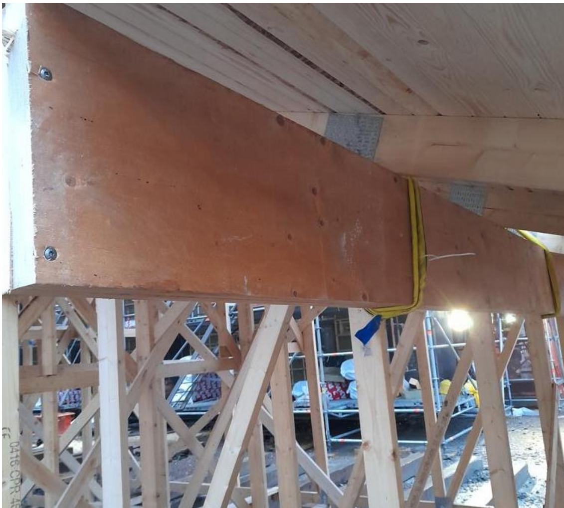
Kuva 14. Vesikaton lohkojen nostopalkki. (Alsaifi 2022)
