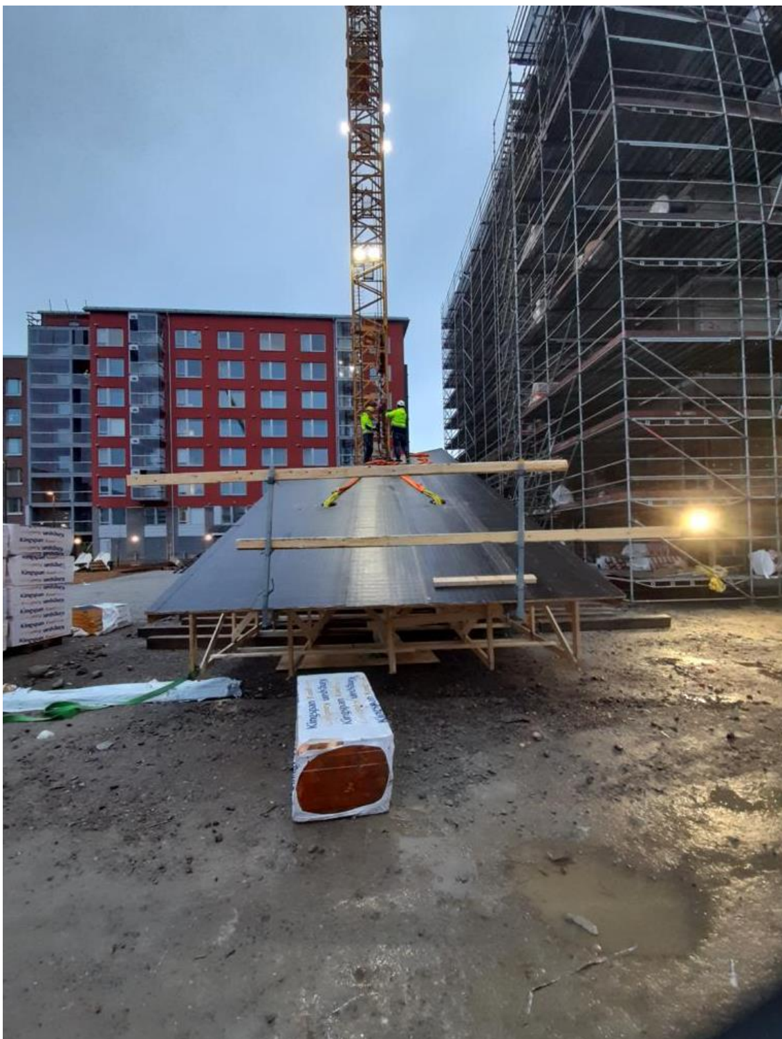
Kuva 2. Vesikaton rinnalla eteneviä työvaiheita. (Alsaifi 2022)
