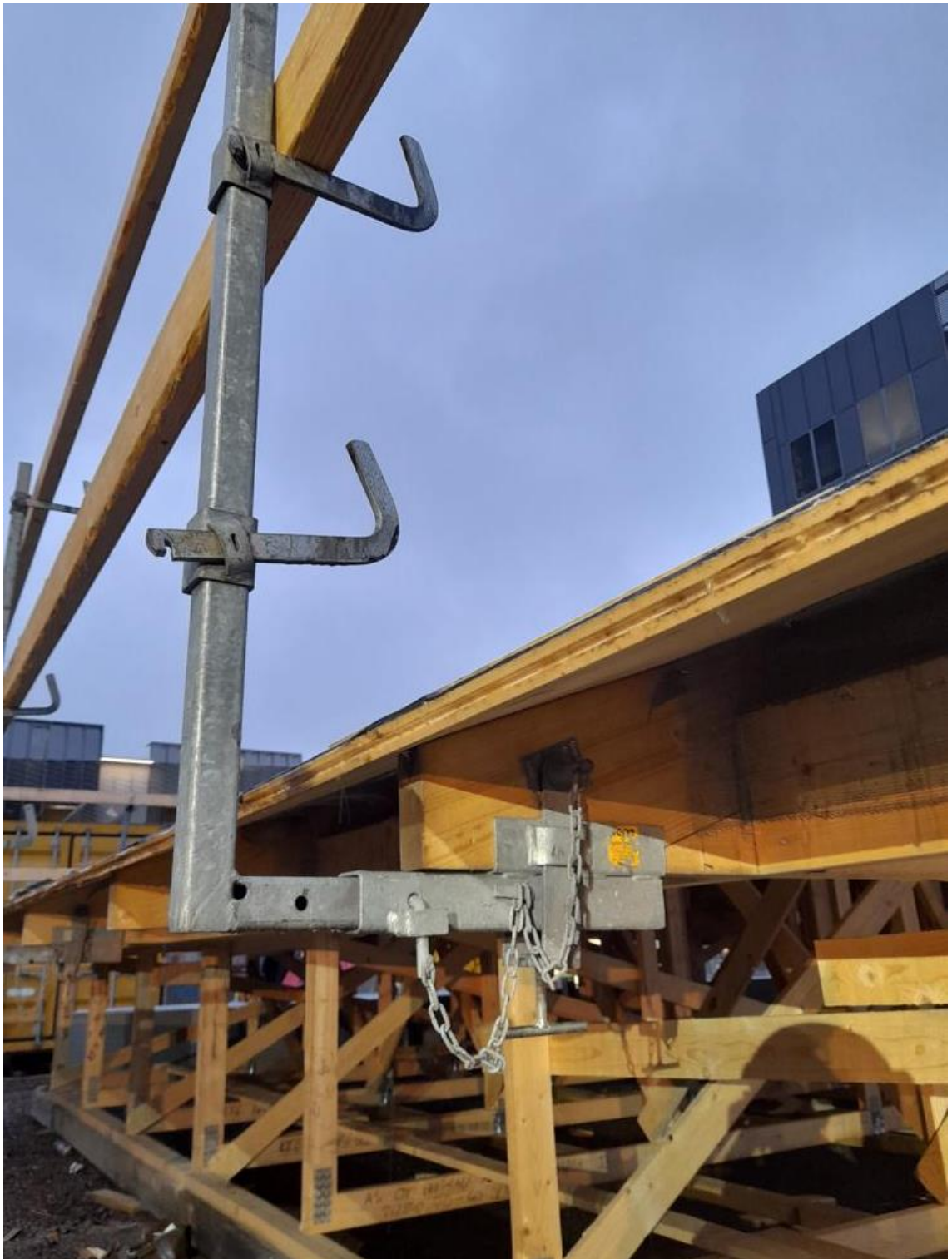
Kuva 10. Vesikaton Vepe-kattokaide on asennettu ennen vesikaton nostoa. (Alsaifi 2022)
