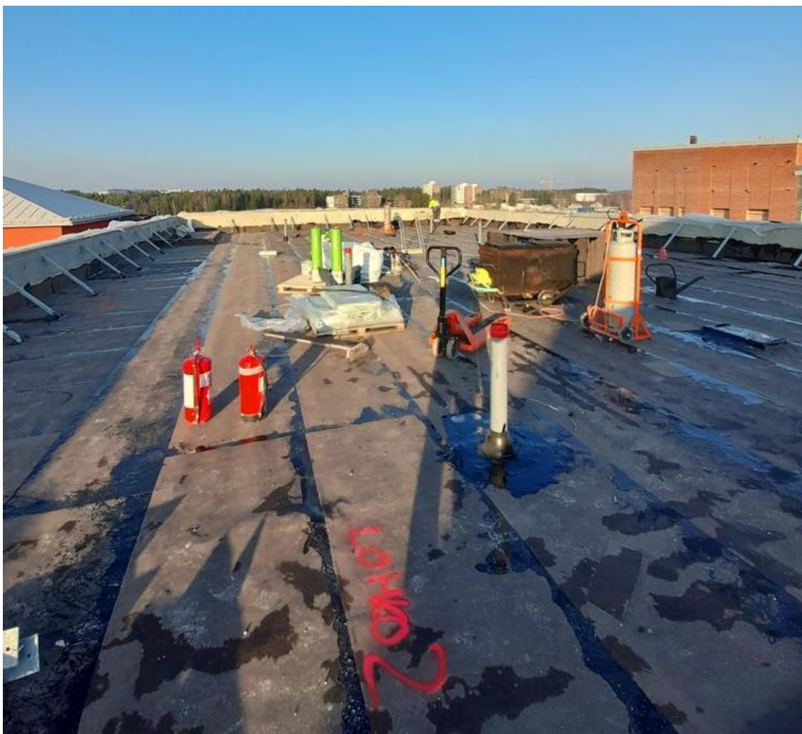
Kuva 8. Vesikaton bitumi työt ja läpivientien tiivistys. (Alsaifi 2022)
