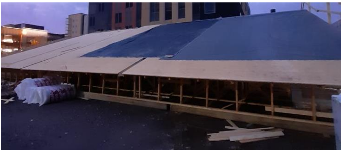
Kuva 7. Vesikaton päivittäinen suojaus. (Alsaifi 2022)
