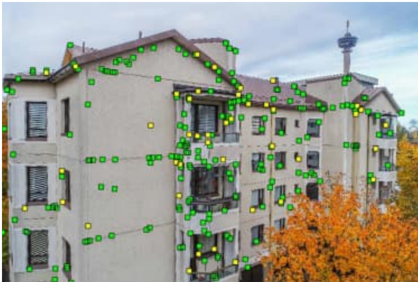
Kuva 6 Vastinpisteitä todellisesta rakennuksesta (A-Insinöörit Suunnittelu Oy 2019)
