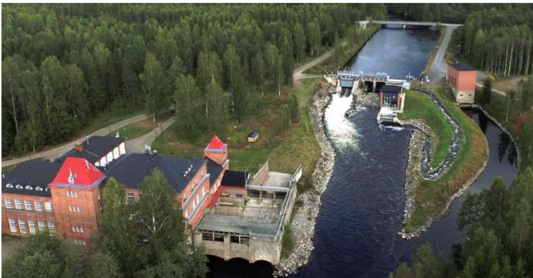
Kuva 11. Kissakosken vesivoimalaitos Hirvensalmella (Hirvensalmi.fi)
