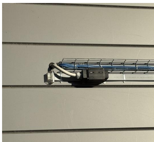
Figur 16. Tillföringsmodul vid väggenomföringen
