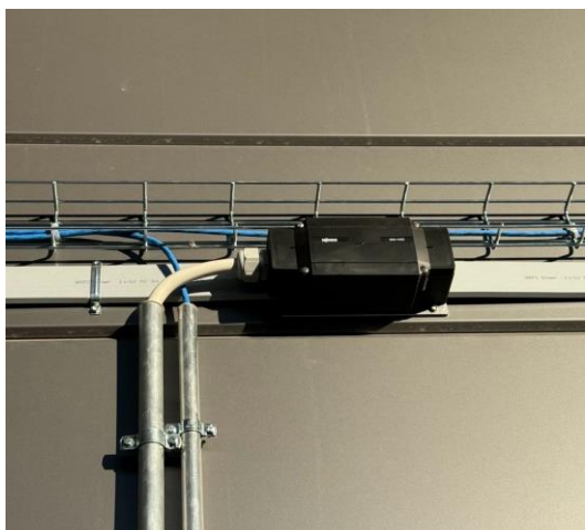
Figur 15. Tillföringsmodul ovanför laddstation
