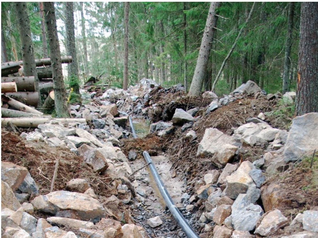
Kuva 5. SRE-putken käyttö haastavissa olosuhteissa (Pipelife Oy www-sivut 2023)
