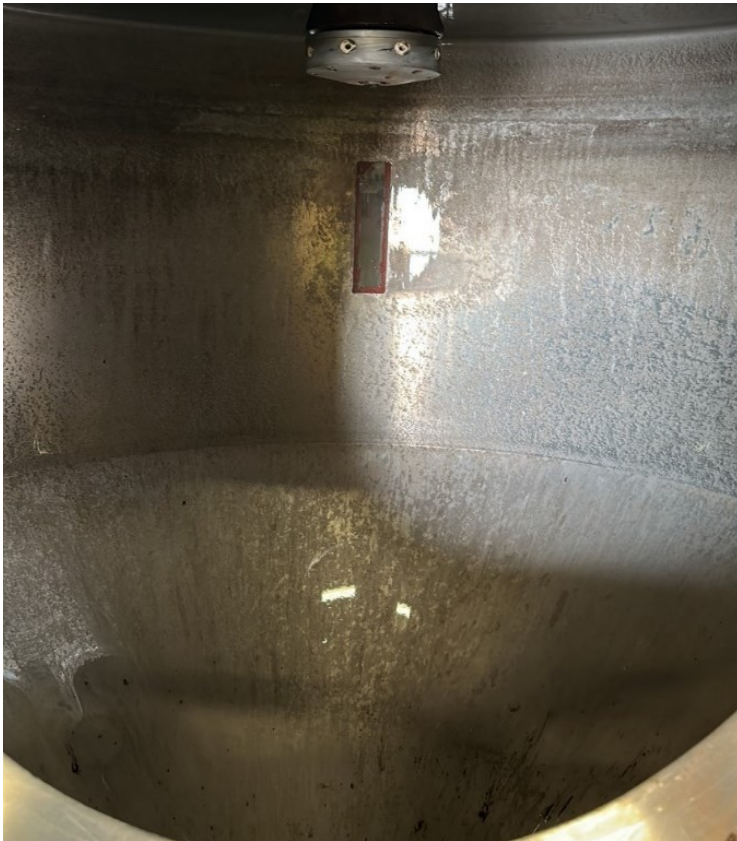
KUVA 2. Puhdistettu spraykuivaimen kammio (Andersson 2023.)
