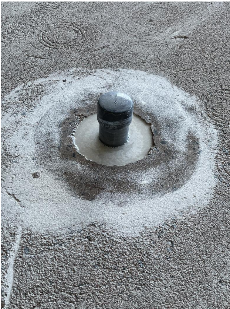
Kuva 10. Altaan pohjasuutin. Kuva: Rauman Kampus
