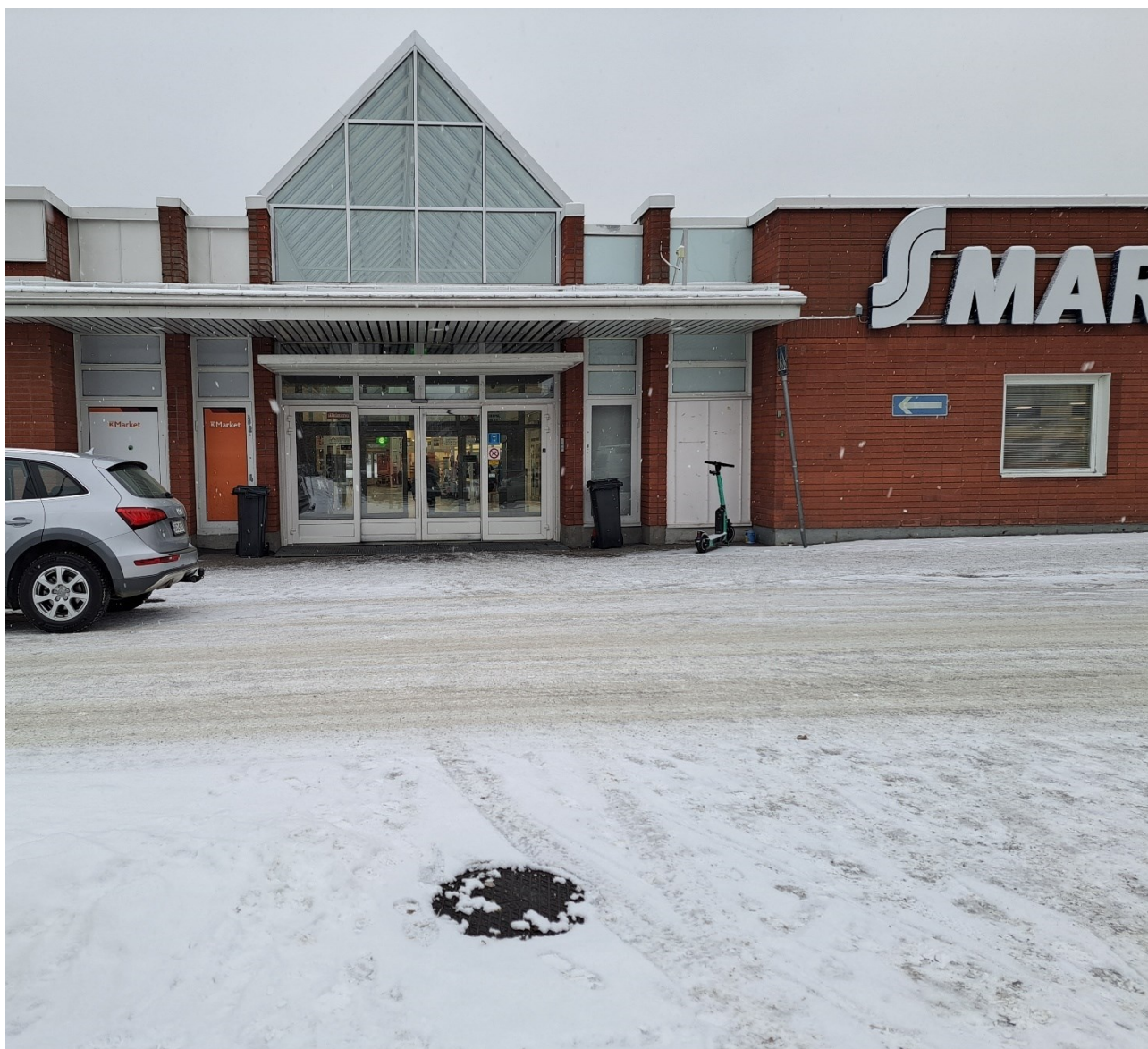
Kuva 22. Puijonlaakson kauppakeskuksen pääsisäänkäynti
