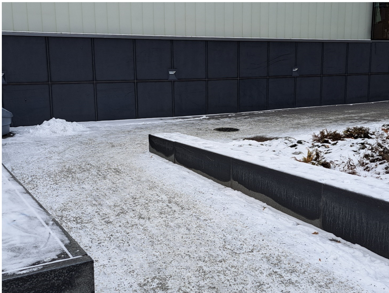
Kuva 2. Esteetön kulkutie pääsisäänkäynnille, Maaherrankadun puolella
