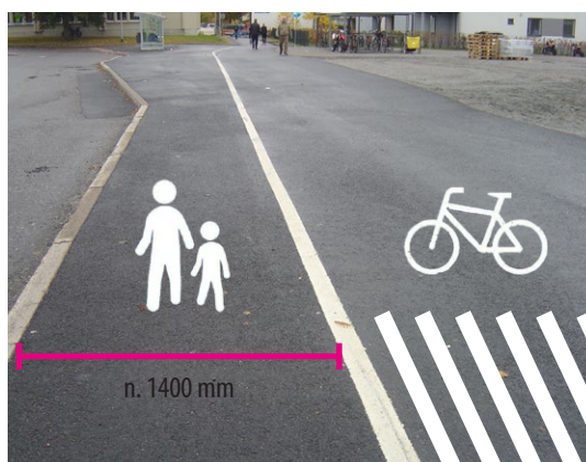
Kuva 14b. Turvallisuutta lisäävien merkintöjen maalaaminen linja-autoasemalla olevaan kevyenliikenteen väylään (ks. s.50).
