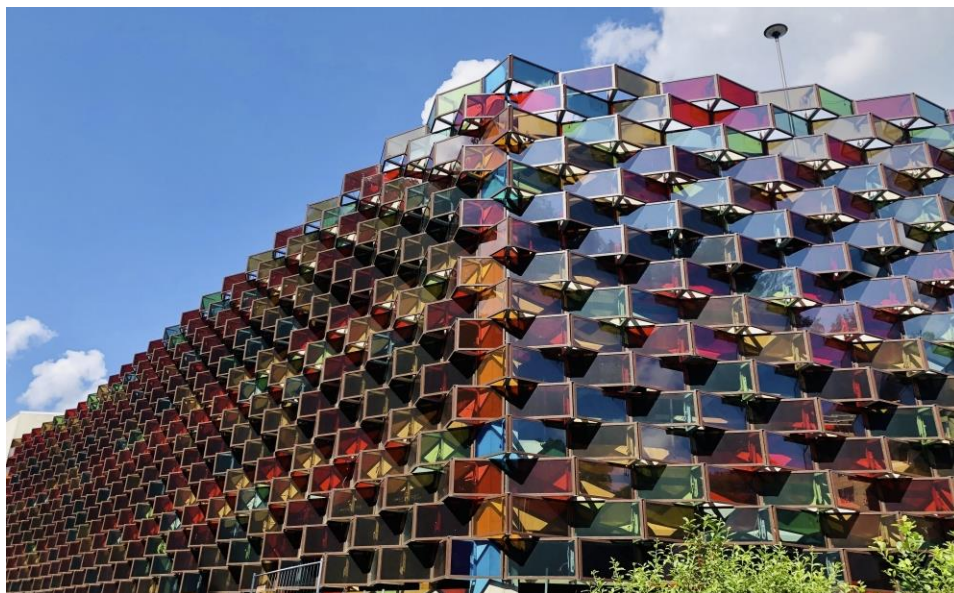
Figur 6. Byggnadintegrerade semitransparenta solcellsmoduler. (fasadsystem.se 2023).
