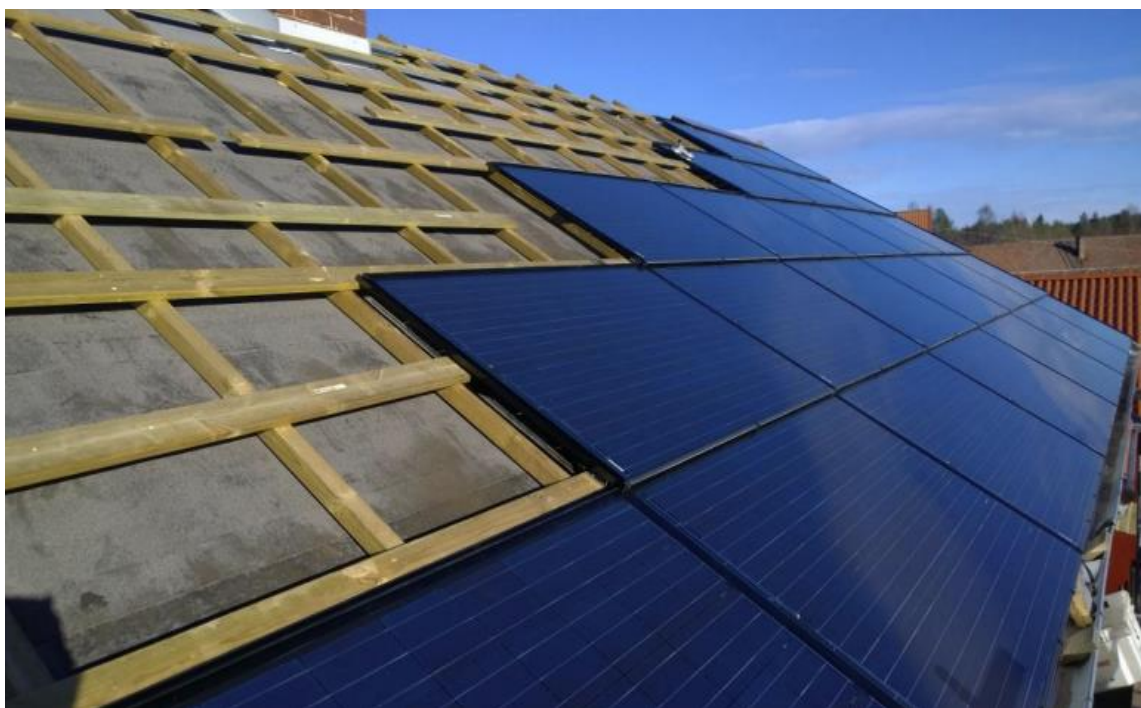
Figur 8. Solid Solrif helsvarta moduler i monteringskede. (solitek.eu 2023)
