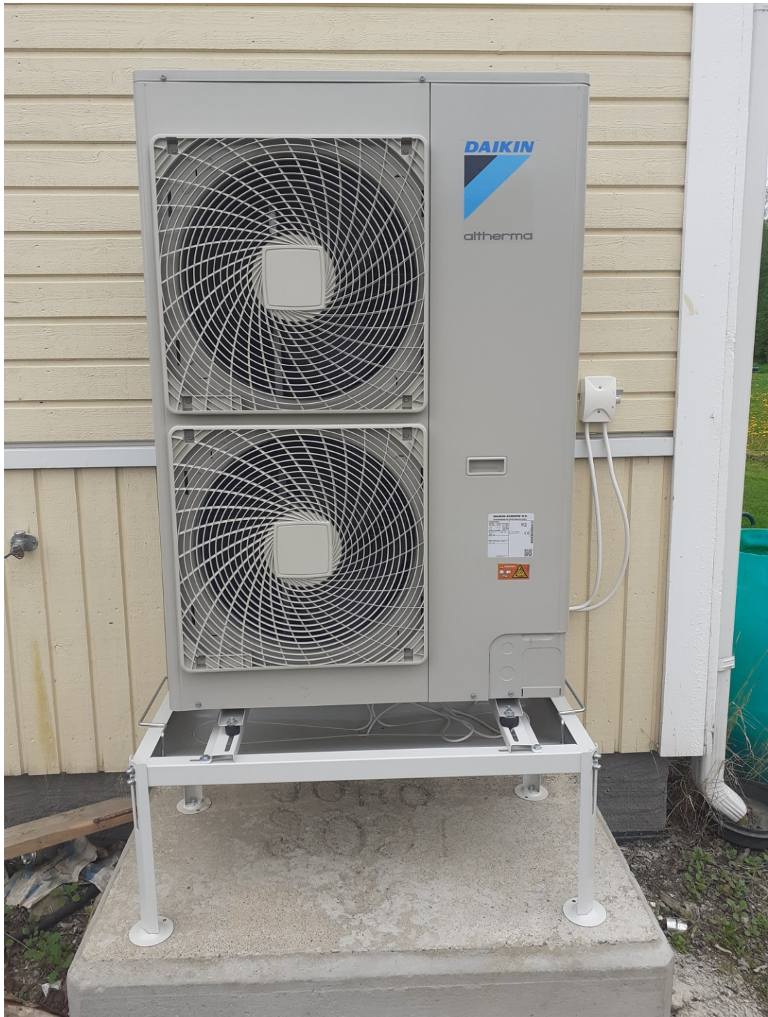
Kuva 10. Ilmavesilämpöpumpun ulkoyksikkö. (Porola, H. 2022)
