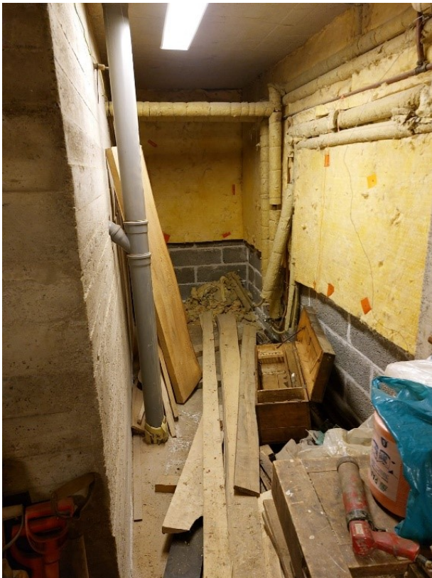
Kuva 3. Asuinrakennuksen kellaritila oikea puoli. (Porola, M. 2021)
