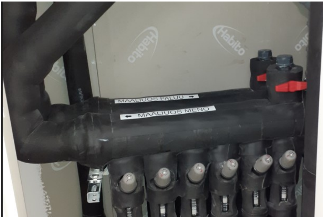
Kuva 6. Keruupiirin nesteen meno- ja paluuputkien merkintä. (Porola, M. 2020)
