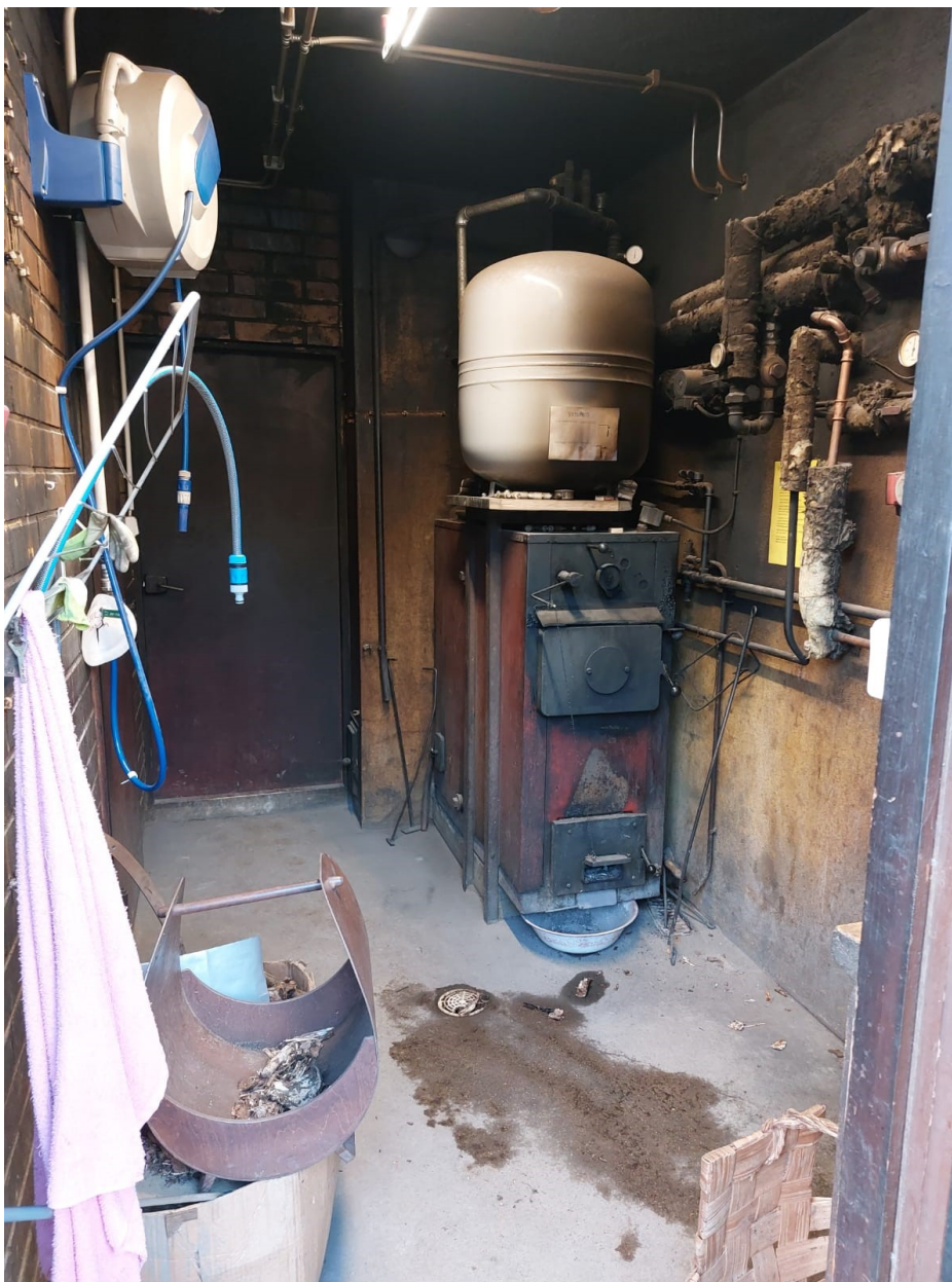
Kuva 1. Maatilan tekninen tila, joka sijaitsee hevostallissa. Alkuperäinen puukattila vuodelta 1976. (Porola, H. 2022)
