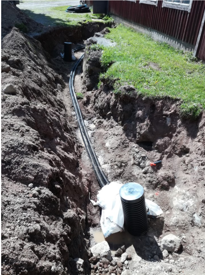
Kuva 7. Vinoporatut maalämpökaivot (Porola, M. 2017)
