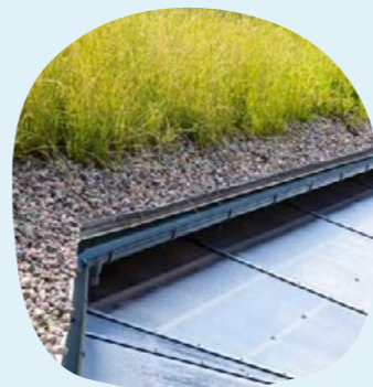
Viherkattokokeilujen suunnittelu Hollolan Rakennusbetoni ja -Elementti kanssa
