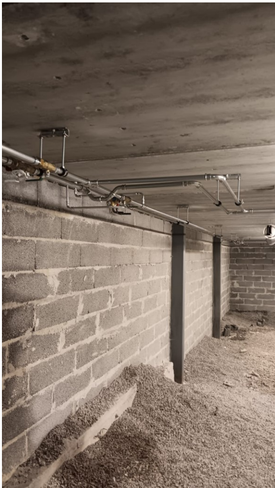
Kuva 4 Uusi patterilinja alapohjassa
