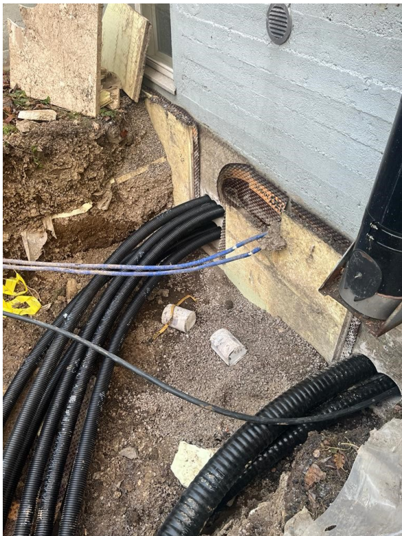
Kuva 10 Läpiviennit rakennukseen kaivannossa
