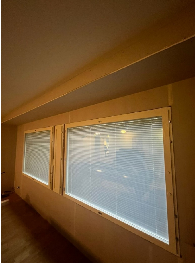
Kuva 6 Uusien ikkunoiden malliasennu & lämpölinjan kotelointi
