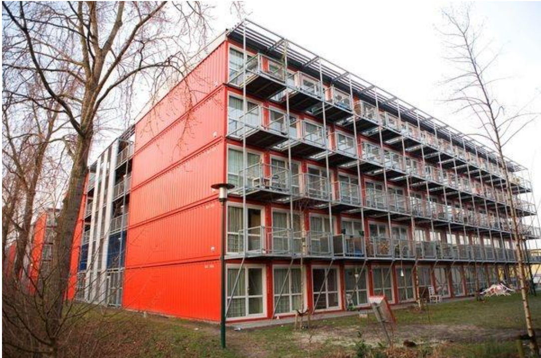
Kuva 1. Keetwonen kaupunginosassa Amsterdamissa sijaitsee konteista rakennettu opiskelija-asuntola [2].
