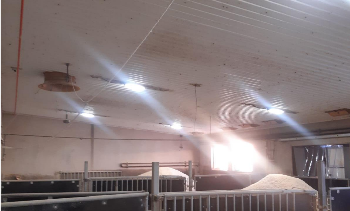
KUVIO 4 Osaston alipaineinen ilmanvaihtojärjestelmä (Suvi Hietala)
