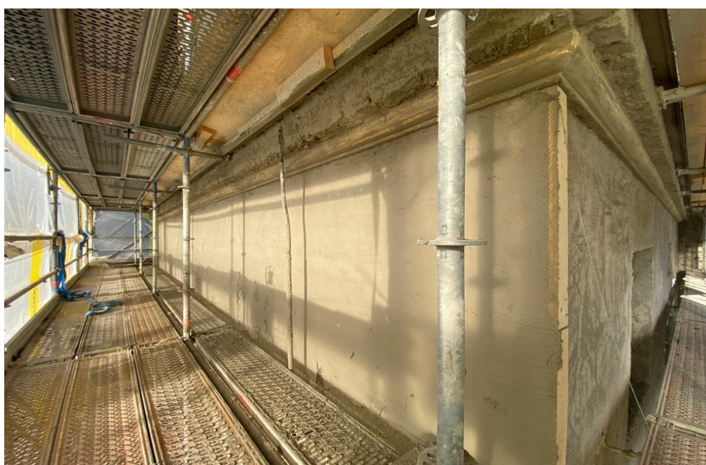
Kuva 8. Rappausjohteet kiinnitetty seinään ennen täyttörappausa (Kuva: Joonas Tarkkonen, 2023).
