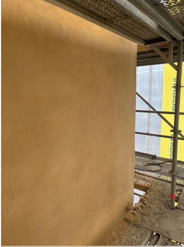
Kuva 12. Seinään on tehty kolme käsittelykertaa kalkkimaalilla (Kuva: Joonas Tarkkonen, 2023).
