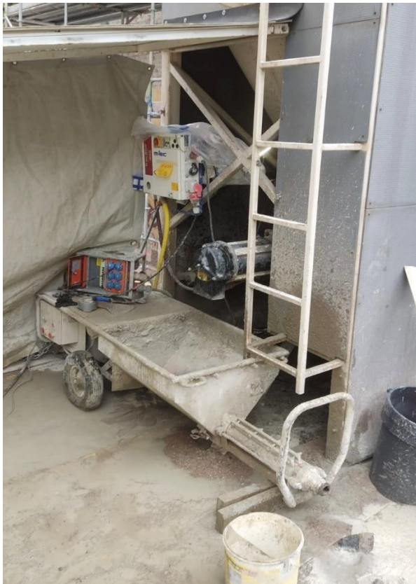
Kuva 13. Työmaalla oleva rappauskalusto, pumppu, siilo, sähköt (Kuva: Joonas Tarkkonen, 2023).
