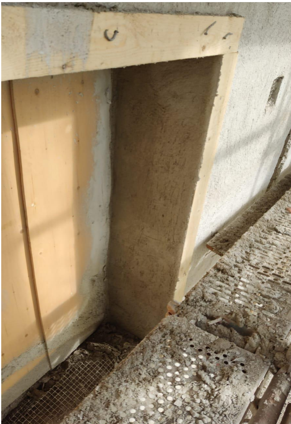
Kuva 9. Rappausjohteet kiinnitetty seinään ikkunan smyygien rappausta varten (Kuva: Joonas Tarkkonen, 2023).
