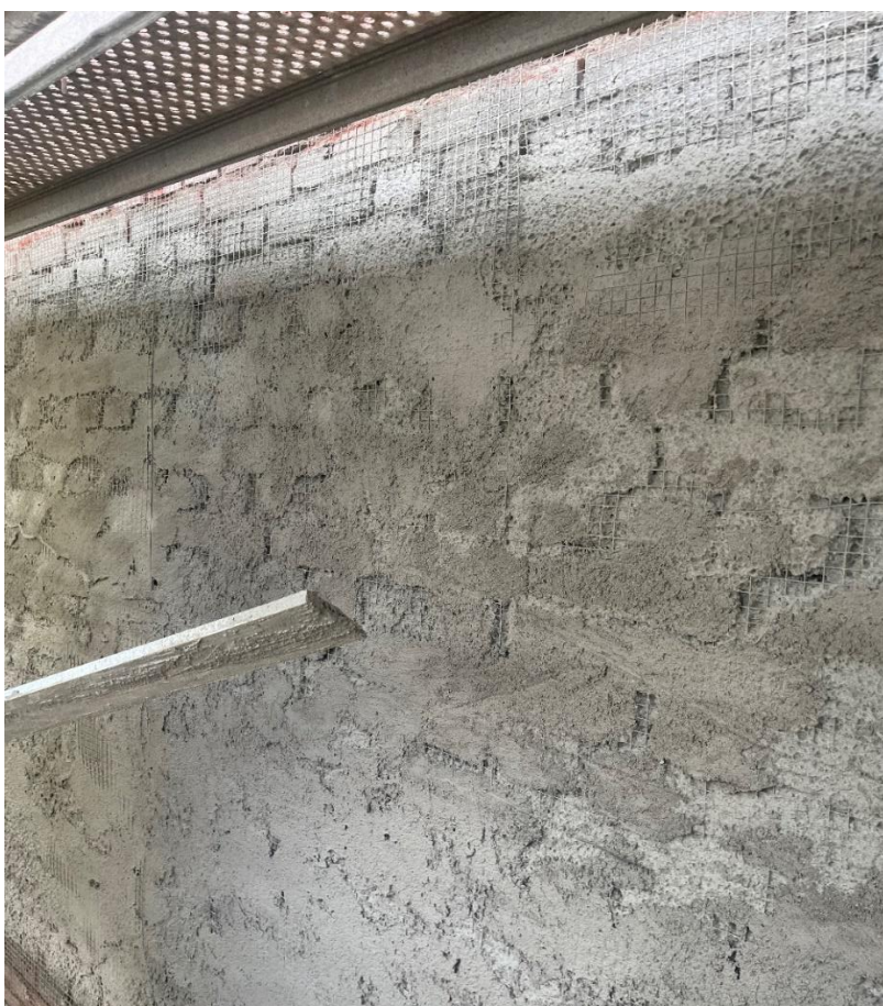
Kuva 7. Tartuntarapattu seinä, seinän oikaisu ja tasaus käynnissä (Kuva: Joonas Tarkkonen, 2023).
