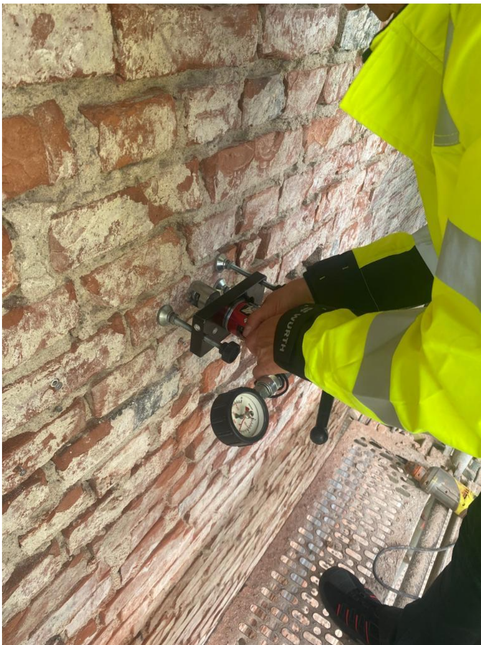
Kuva 5. Mekaanisen kiinnikkeen vetokoe rappausalustalla (Kuva: Joonas Tarkkonen, 2023).
