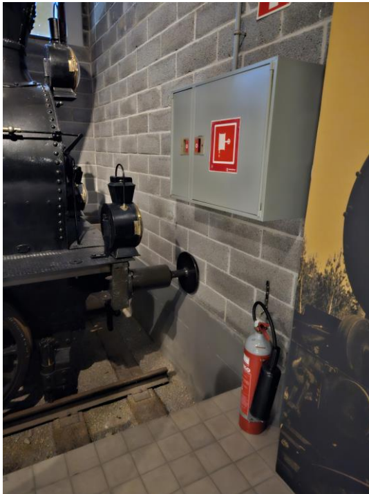
Kuvio 7: Alkusammutuskaappi junaraiteen yläpuolella
