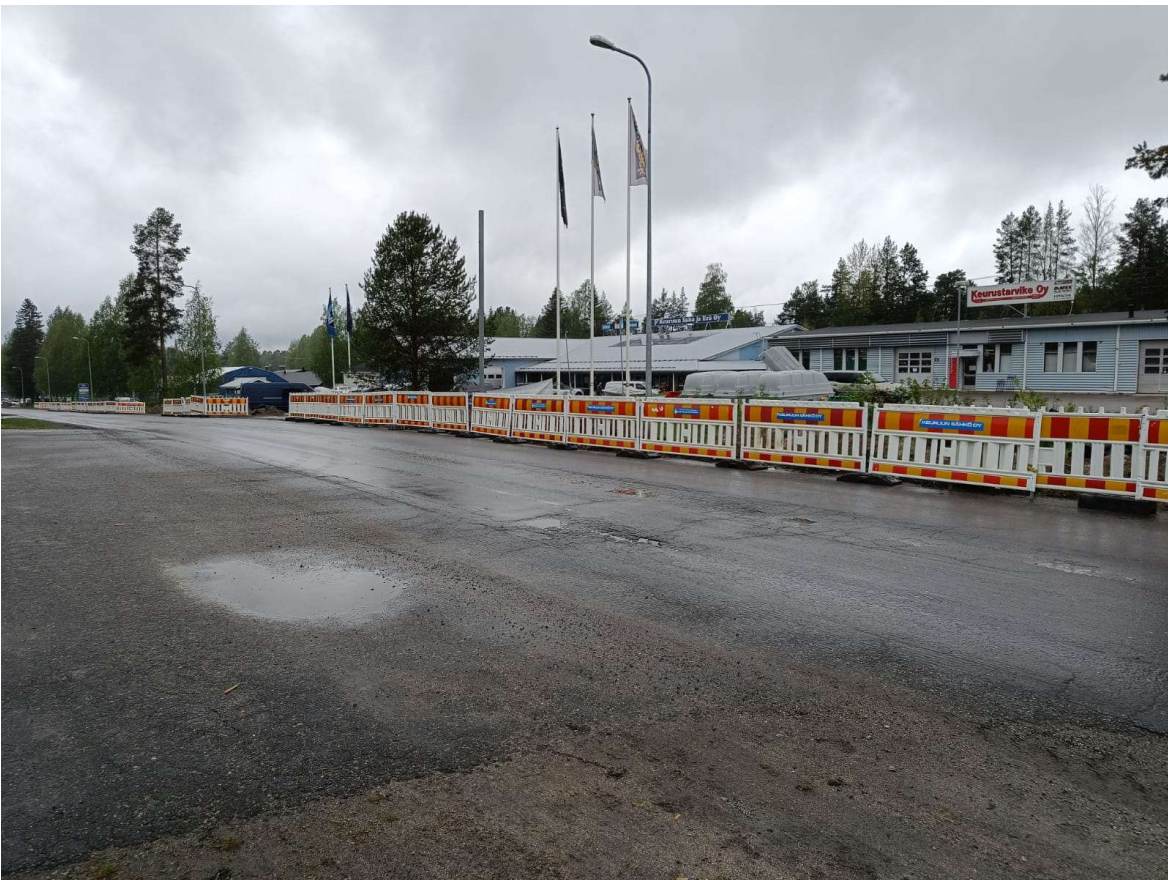
Kuvio 14. Kaapelikaivannon suojaus kadun varressa.
