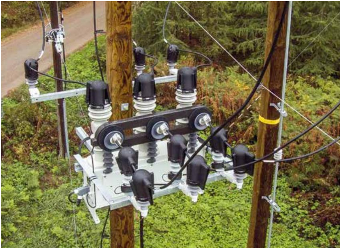
KUVA 8. Ensto Smartcloser pylväskatkaisija (13)
