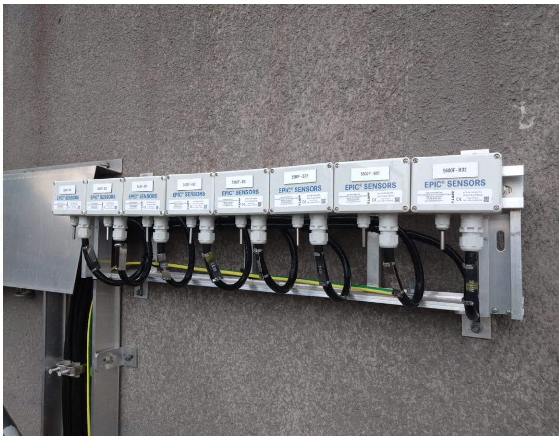
Kuva 6. Uudet PT100-anturit muuntamorakennuksen M028 ulkoseinällä.
