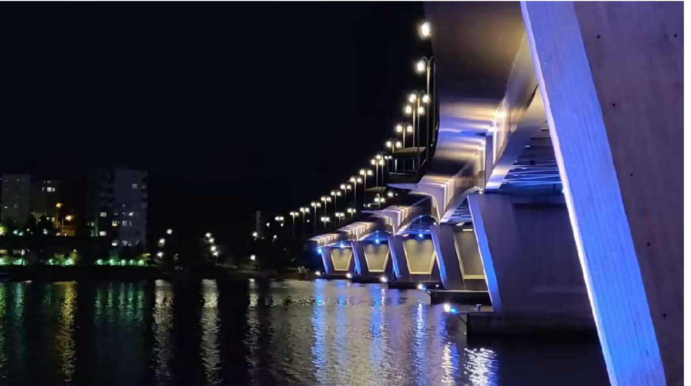
Kuvio 2 Kuokkalan silta, Jyväskylä Kuva: Niko Mannonen / Yle
