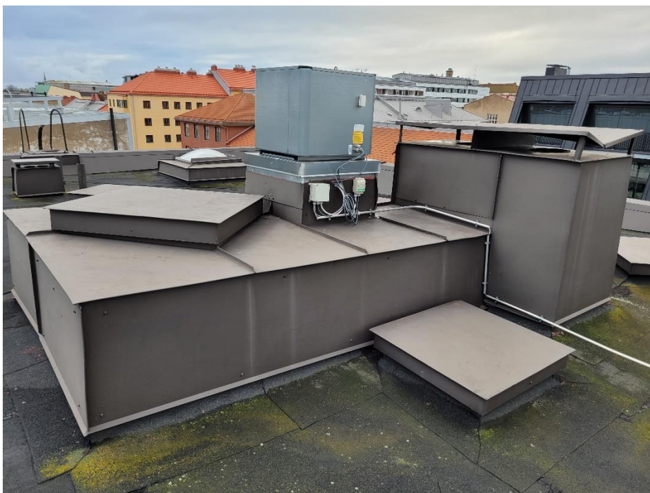
Kuva 1. Kohteen katolla sijaitseva poistopuhallin.
