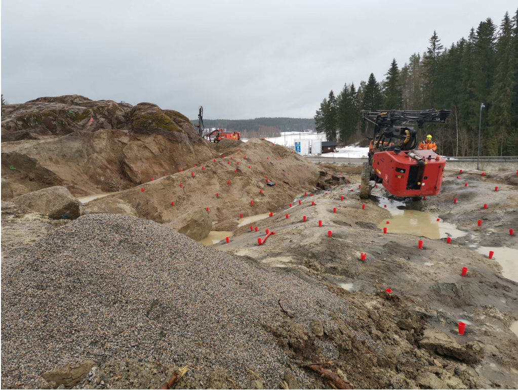
KUVA 17. Louhintatyöt rakennusalueella maaliskuussa 2023
