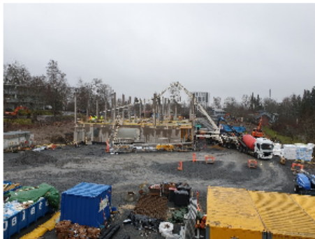
Yleiskuva työmaasta, ontelolaattakentän saumavalu käynnissä
