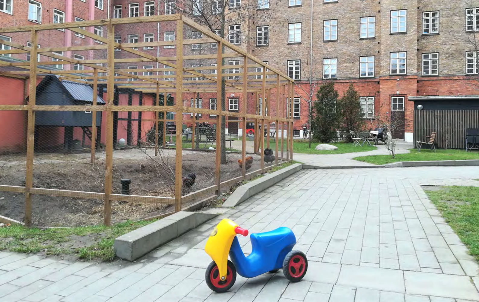
Hulevesiratkaisuja asuinkorttelin sisäpihalla Kööpenhaminassa. Sisäpihalla hulevesiviemärit on korvattu hulevesipainanteilla, jotka toimivat myös mm. osana kanatarhaa.
