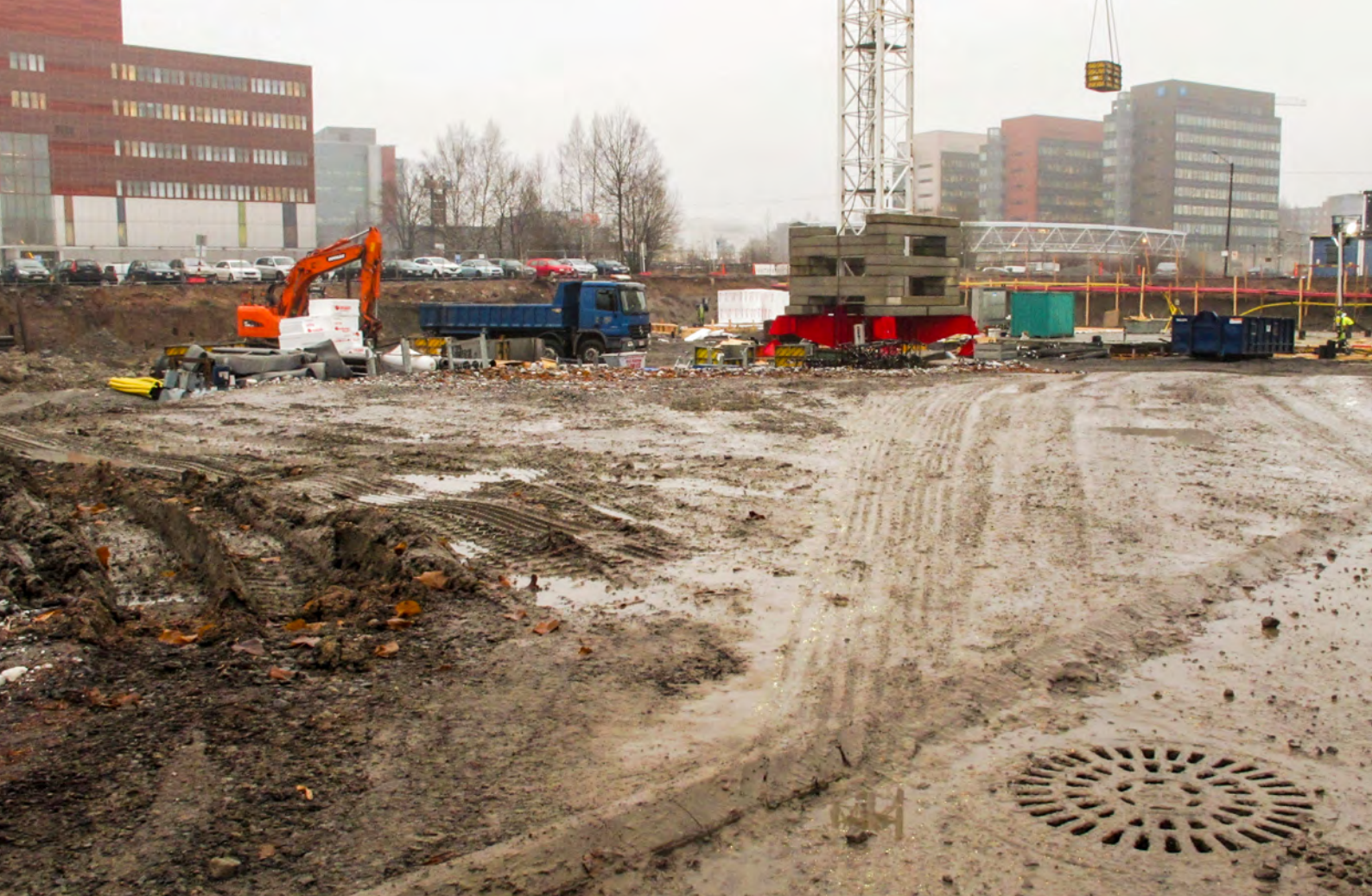
Rakennustyömaat voivat olla hulevesiin päätyvän kuormituksen merkittävä päästölähde.
