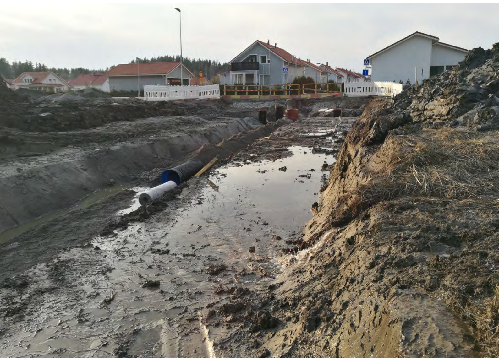
Rakennustyömaat voivat olla hulevesiin päätyvän kuormituksen merkittävä päästölähde.
