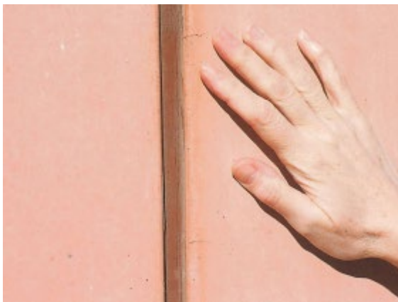
KUVA 5. Ns. lyijykynäpyöröstys elementin saumassa (Neuvonen 2014, 44).
