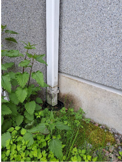
KUVA 20. Kattovesien poisto.
