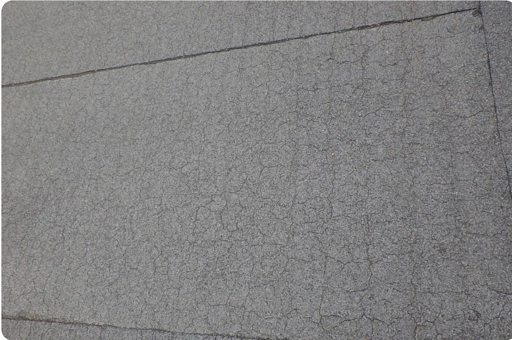
Havainto1 Kate alkaa olemaan teknisen käyttöiän lopussa.
