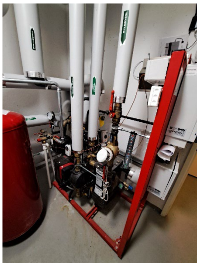
KUVA 48. kaukolämpökeskus.
