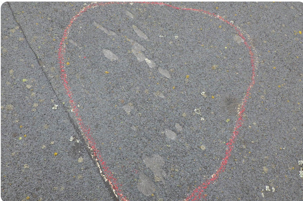
Havainto2 Katteessa on yksittäinen kohta jossa kermin pinta on vaurioitunut ja pintasiroite on irronnut.
