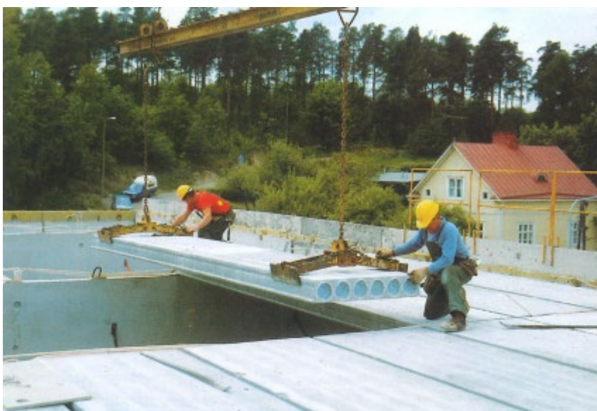
KUVA 10. Ontelolaatta yläpohja (Neuvonen 2014, 56).
