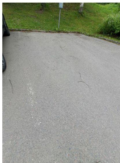
KUVA 15. Asfaltin halkeamat.
