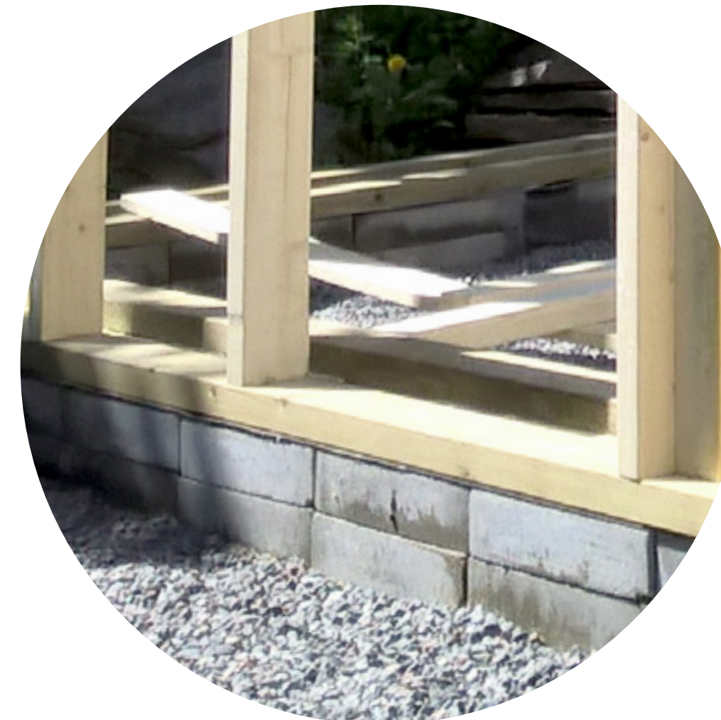
Betonilaattaperustuksen ja alajuoksun välissä on bitumikaista kosteuskatkona.
