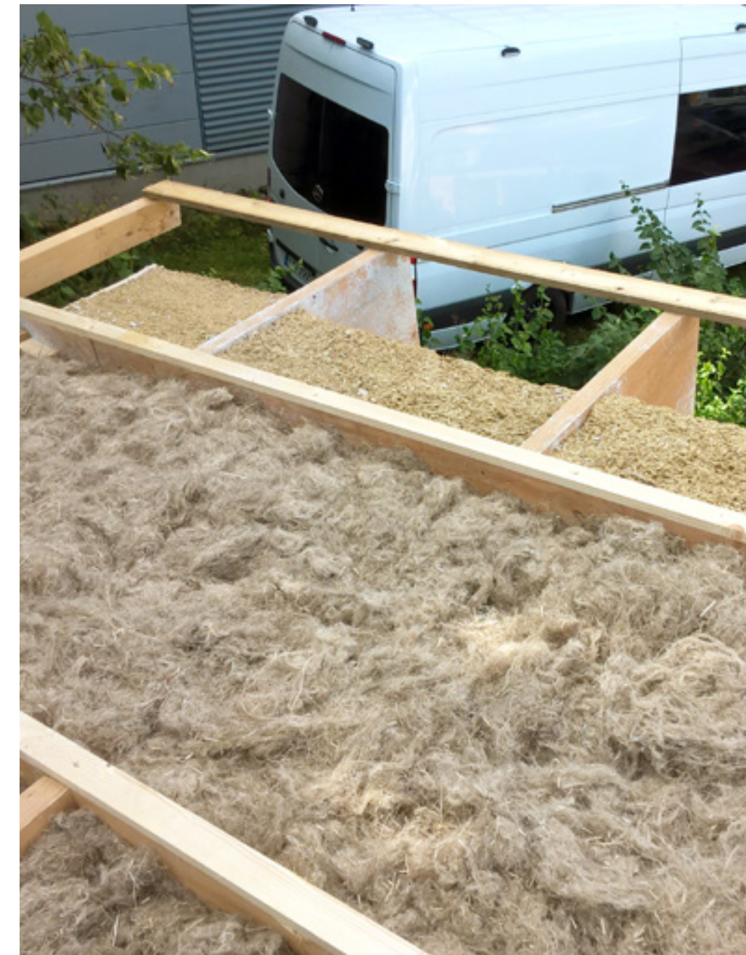
Katon eristämisessä käytettiin hampukuitua
