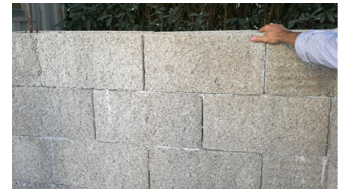
Hamppu-kalkkiseoksesta on mahdollista valmistaa elementti- ja harkkotuotteita. Hamppu voidaan yhdistää myös saven kanssa toimiviksi tuotteiksi.
