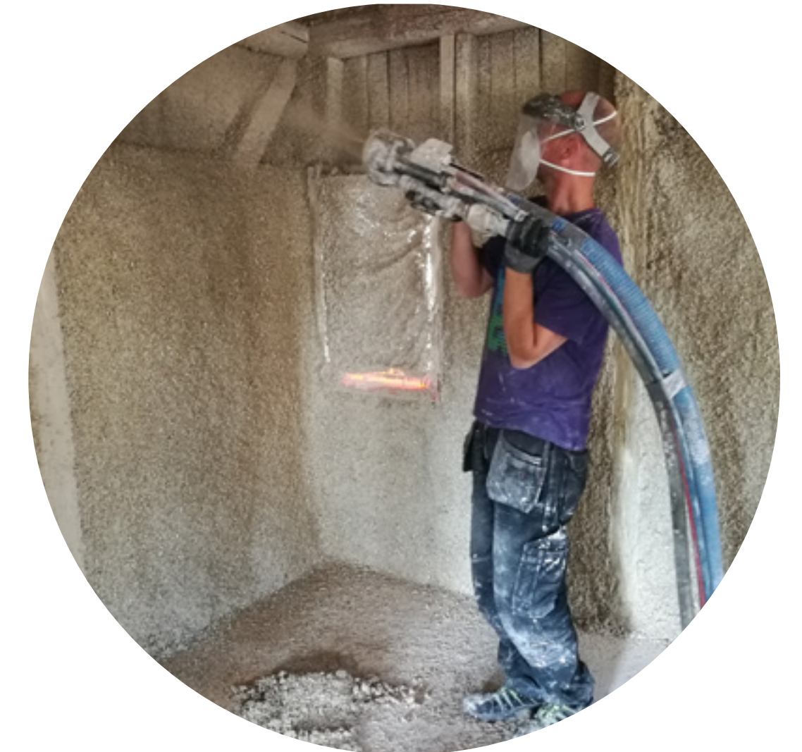
Ruiskuvalutekniikka soveltuu erityisesti korjausrakentamiseen ja lisäeristämiseen.
