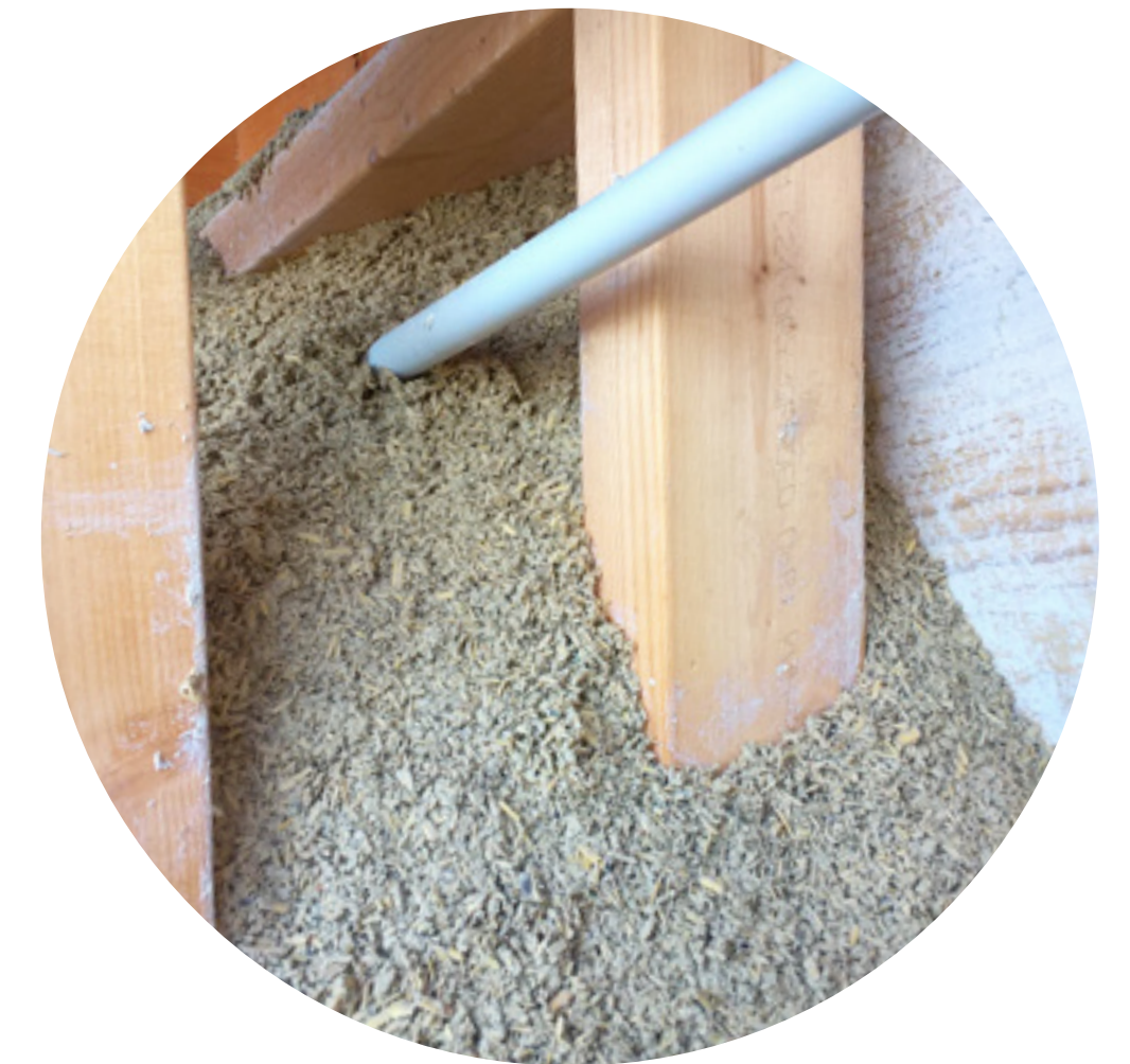
Sähköjohtojen putkitus jätettiin hamppuvalun sisään.
