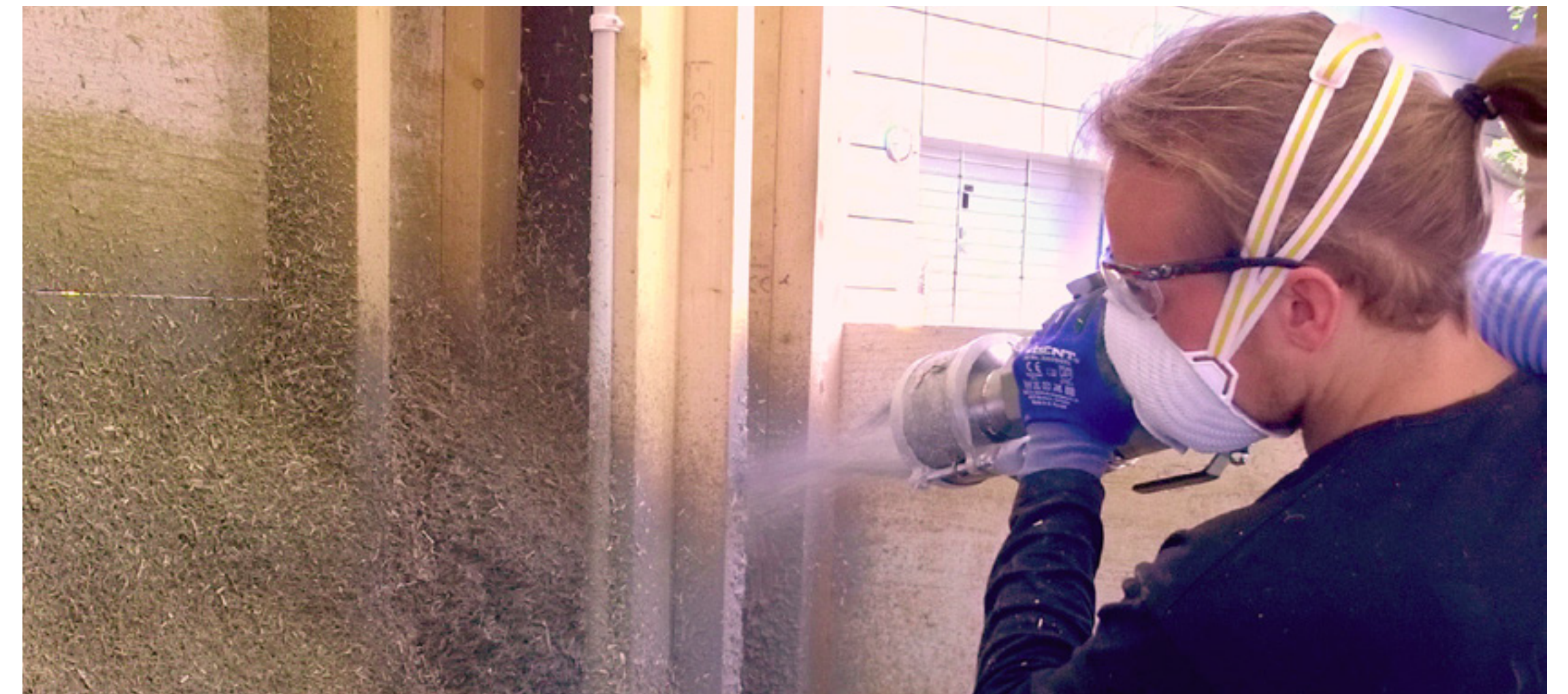
Koerakennuksen takaseinä toimi ruiskuvalutekniikan harjoittelualustana.
