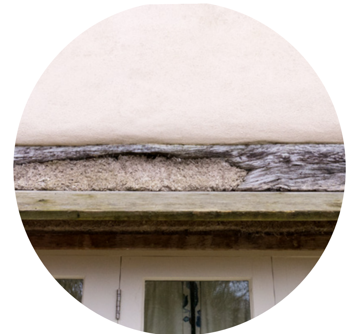
Lahonneita hirsirakenteita on mahdollista korjata hampu-kalkkimassan avulla.
