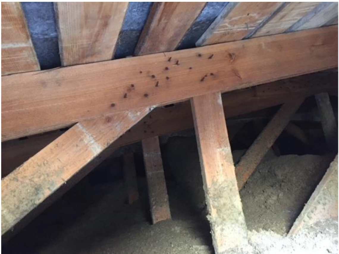
Kuva 21. Vuonna 1968 valmistuneen paritalon, olosuhdemittauskohde 2, yläpohjaan on lisätty puhallusvillaa, joka on valmistettu silputusta kivivillasta. Lisälämmöneristeen asennusajankohta ei ole tiedossa, Kuva Mikko Niskanen 2019
