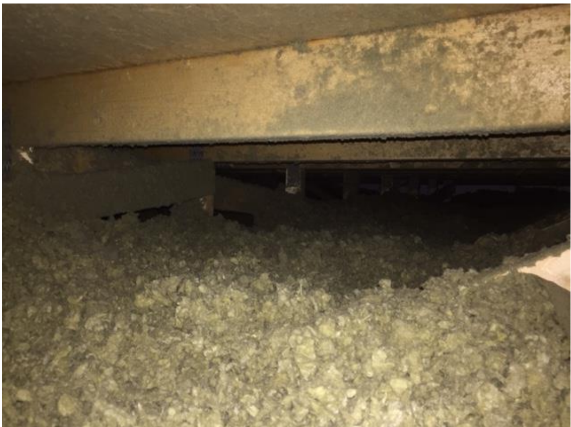
Kuva 19. Vuonna 2016 valmistuneen omakotitalon, olosuhdemittauskohde 1 yläpohjassa käytetty puhallusvillaa, joka on valmistettu silputusta kivivillasta, Kuva Mikko Niskanen 2019
