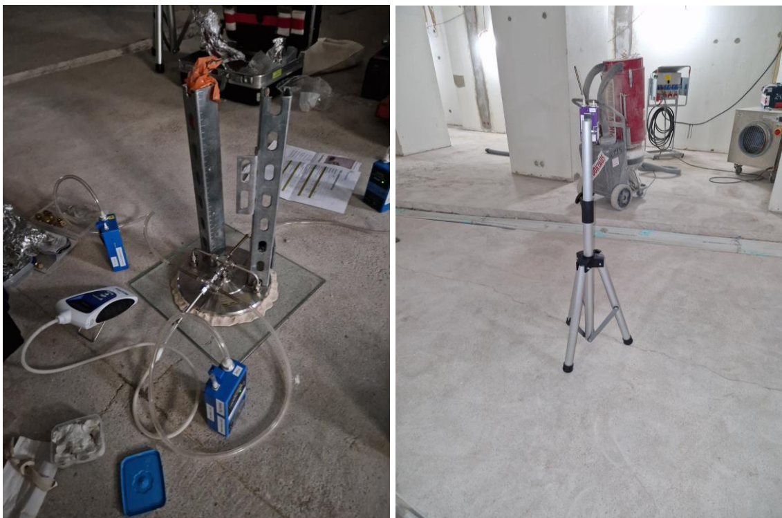
Kuva 6. Vasemmalla, työmaa-aikainen FLEC-mittaus, kuva Mikael Valkeejärvi, IdeaStructura Oy
