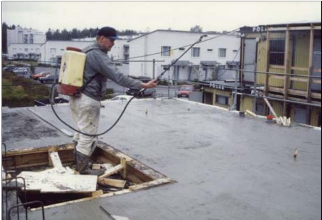
Kuva 19. Kuvassa näkyy mies, joka laita jälkihoito aineita betonilattialle. (29)
