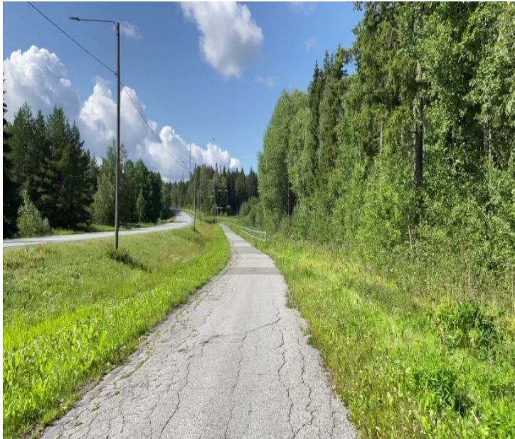
Kuva 7. Laajaksi reiäksi purkautunut verkkohalkeama kävely- ja pyöräilyväylällä (AFRY Finland Oy).
