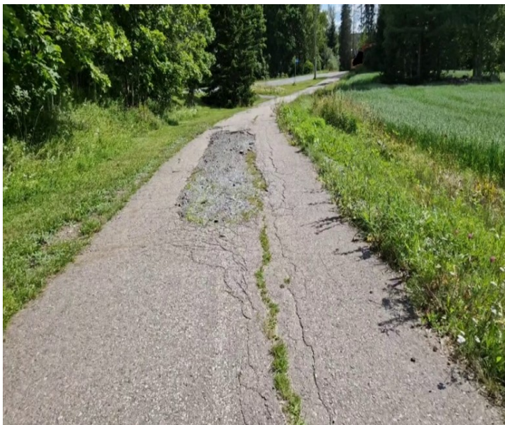
Kuva 7. Laajaksi reiäksi purkautunut verkkohalkeama kävely- ja pyöräilyväylällä (AFRY Finland Oy).
