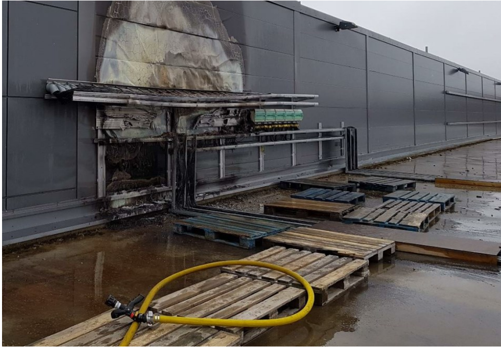
Kuva 14. Rakennuksen katolle rakennettu kulkusilta aurinkopaneelien sammutustyössä [41, s. 17].
