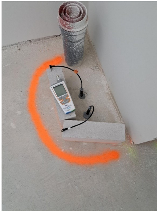
Kuva 6. Betonin suhteellisen kosteuden mittaus porareikämenetelmällä.
