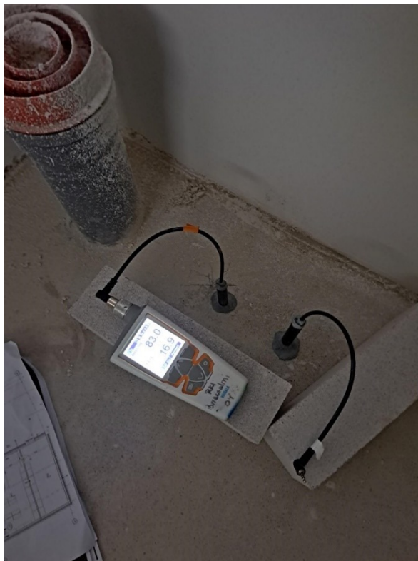
Kuva 10. Betonin suhteellisen kosteuden mittaaminen porareikämenetelmällä
