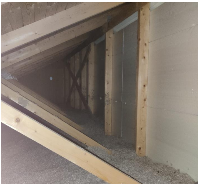
Kuva 3 vuoden 2017 laajennuksen eristeet.
