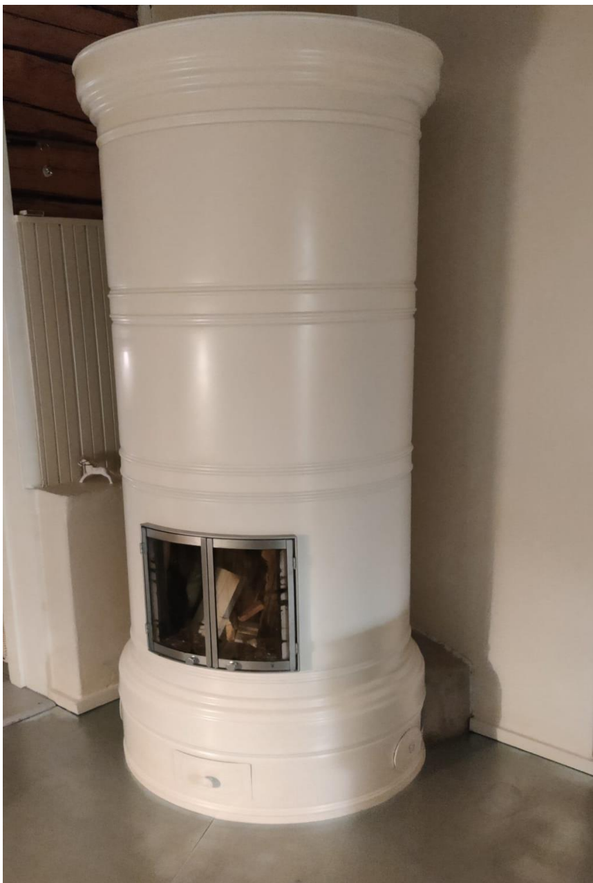
Kuva 8. Talon pönttöuuni asennettuna sydänmuuriin
