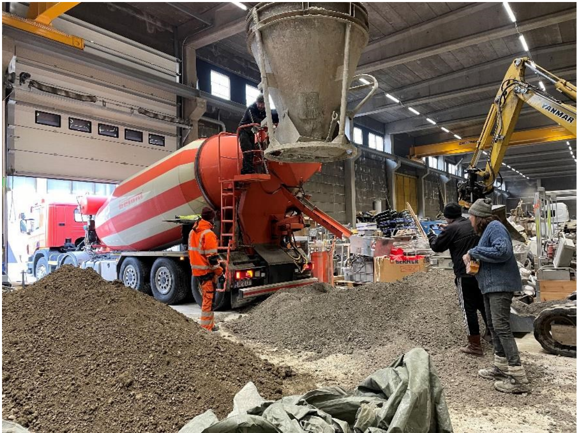
Kuva 2. Luonnonbetonin valmistus käynnissä Vihdin betonin tuotantotilassa. Valokuva: Sampsa Raevaara (2021).
