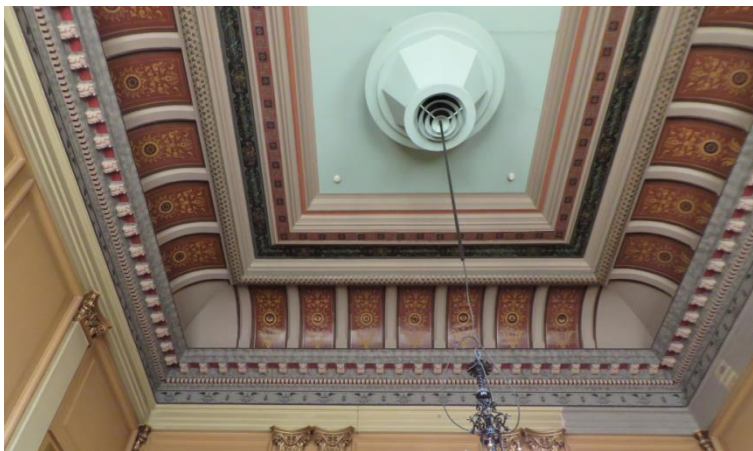
Kuva 63. Porrashuoneen katon rekonstruktio.
