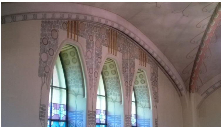
Kuva 92. Alkuperäinen esilleotettu koristemaalaus.
