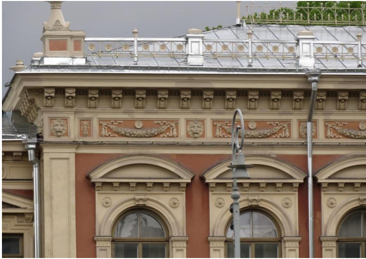
Kuva 34. Julkisivun runsaat kipsikoristeet.
