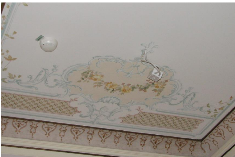
Kuva 72. Alakerran salin alkuperäinen kattomaalaus.
