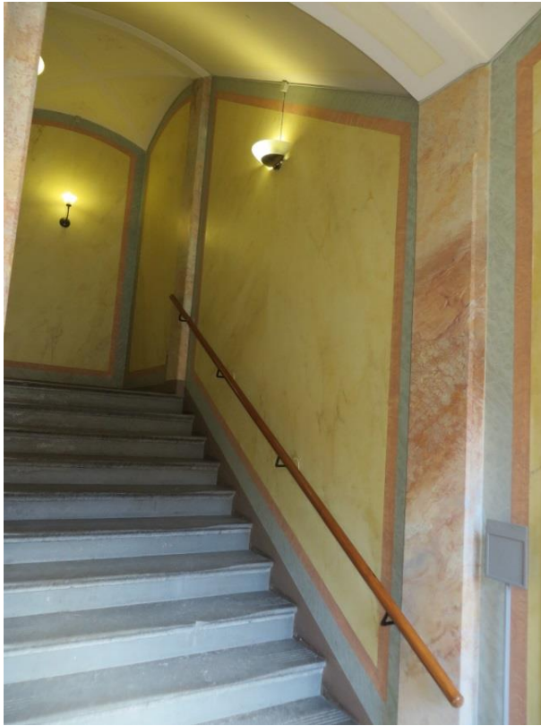
Kuva 23. Brinkkalan talon marmoroitu porraskäytävä.
